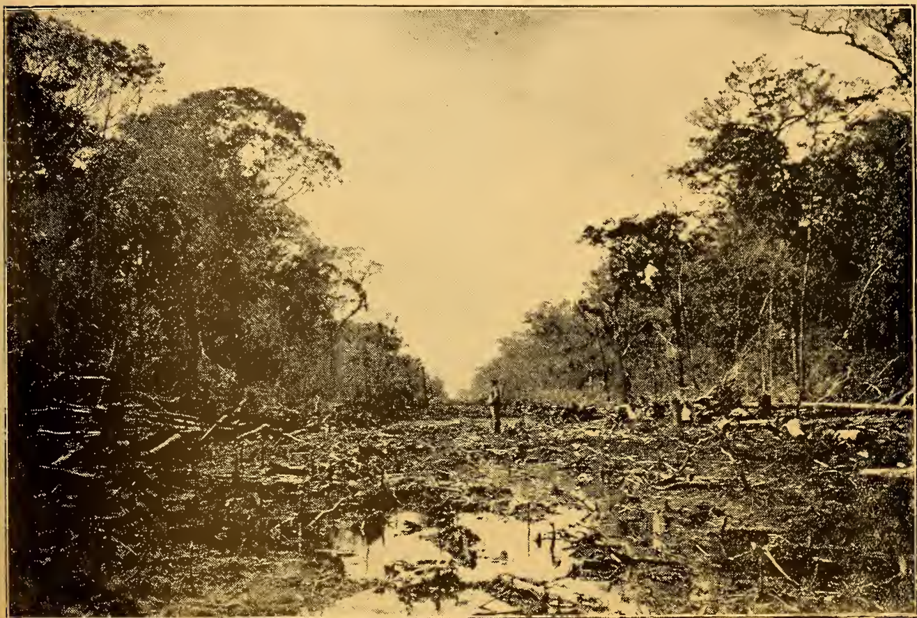
Trecho compreendido entre o Km. 8 e o Oceano
