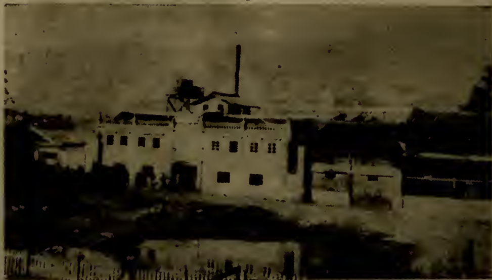
Instalações da fábrica de Yunnan
