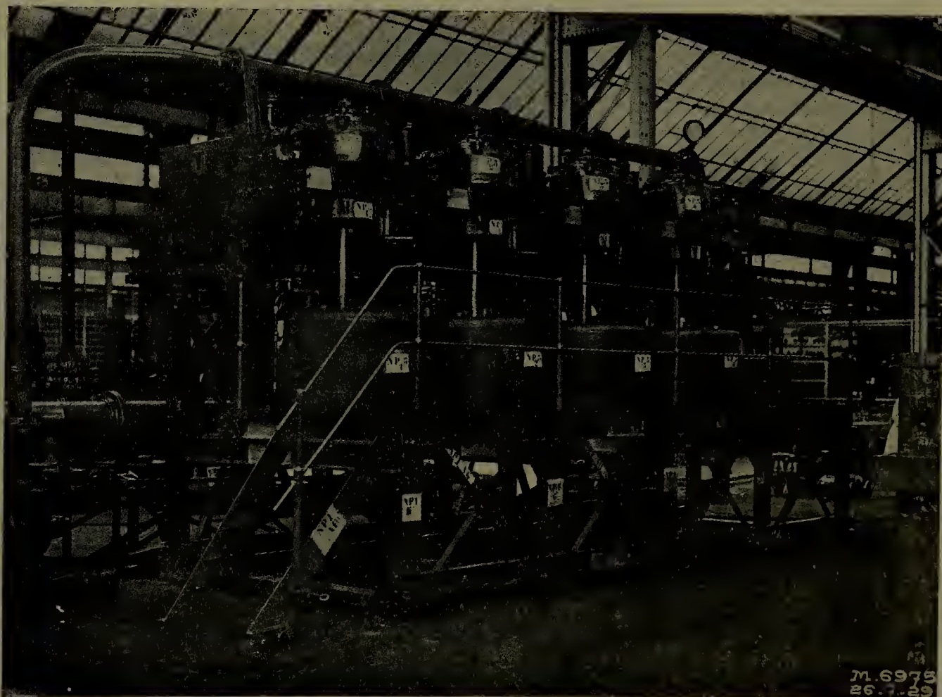
INSTALAÇÃO DE 4 CENTRIFUGAS DE 36'' x 18''
