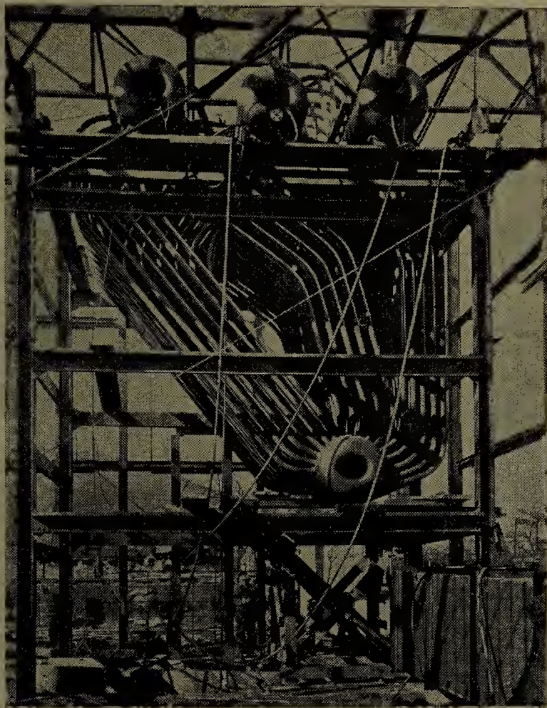
Caldeira C-E, tipo especialmente desenhado para vaporização rápida
