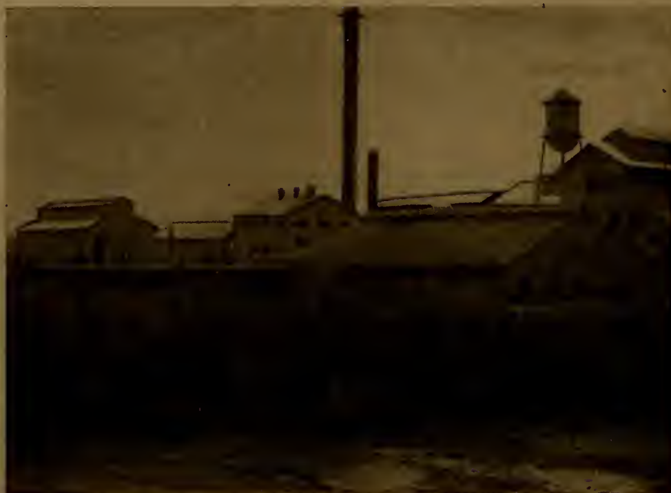
Aspecto da usina de açúcar Los Mochis, no México
