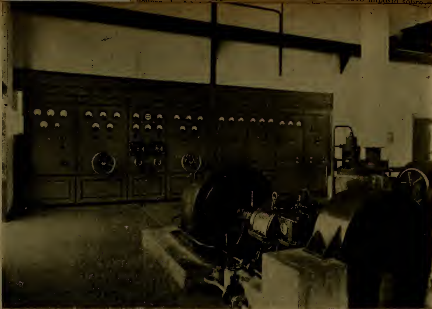
Força motriz — Central elétrica (quadro distribuidor)
