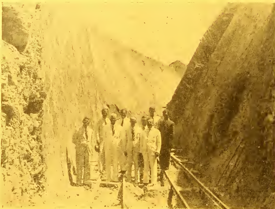
Vê-se nesta fotografia o presidente do I.A.A., em companhia de diretores da Usina Santa Terezinha e outras pessoas, em uma garganta atravessada por um corte de 25 metros de altura, na nova ferrovia de 23 kms. que ligará a Usina à cidade de Palmares.
