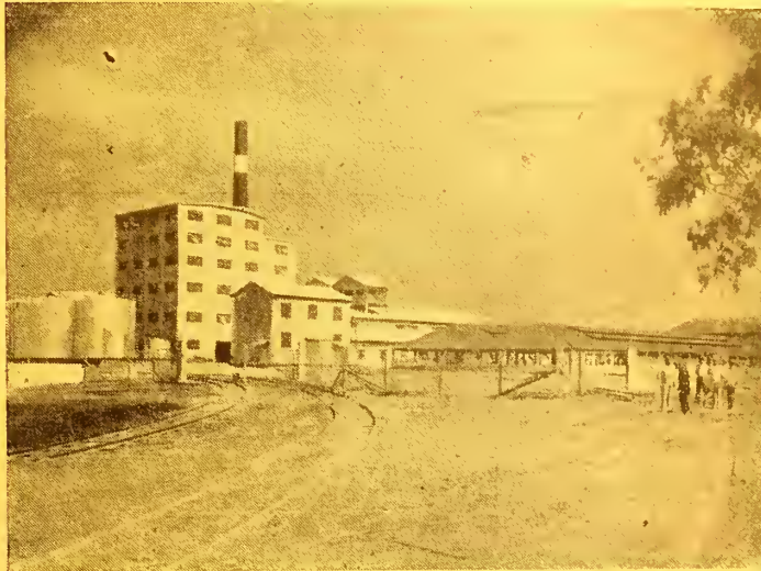
Distilaria Central do Estado do Rio do Instituto do Açucar e do Alcool (Vista geral)
