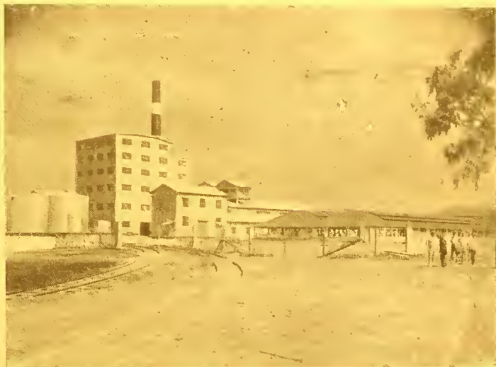
Distilaria Central do Estado do Rio do Instituto do Açúcar e do Alcool (Vista geral)
