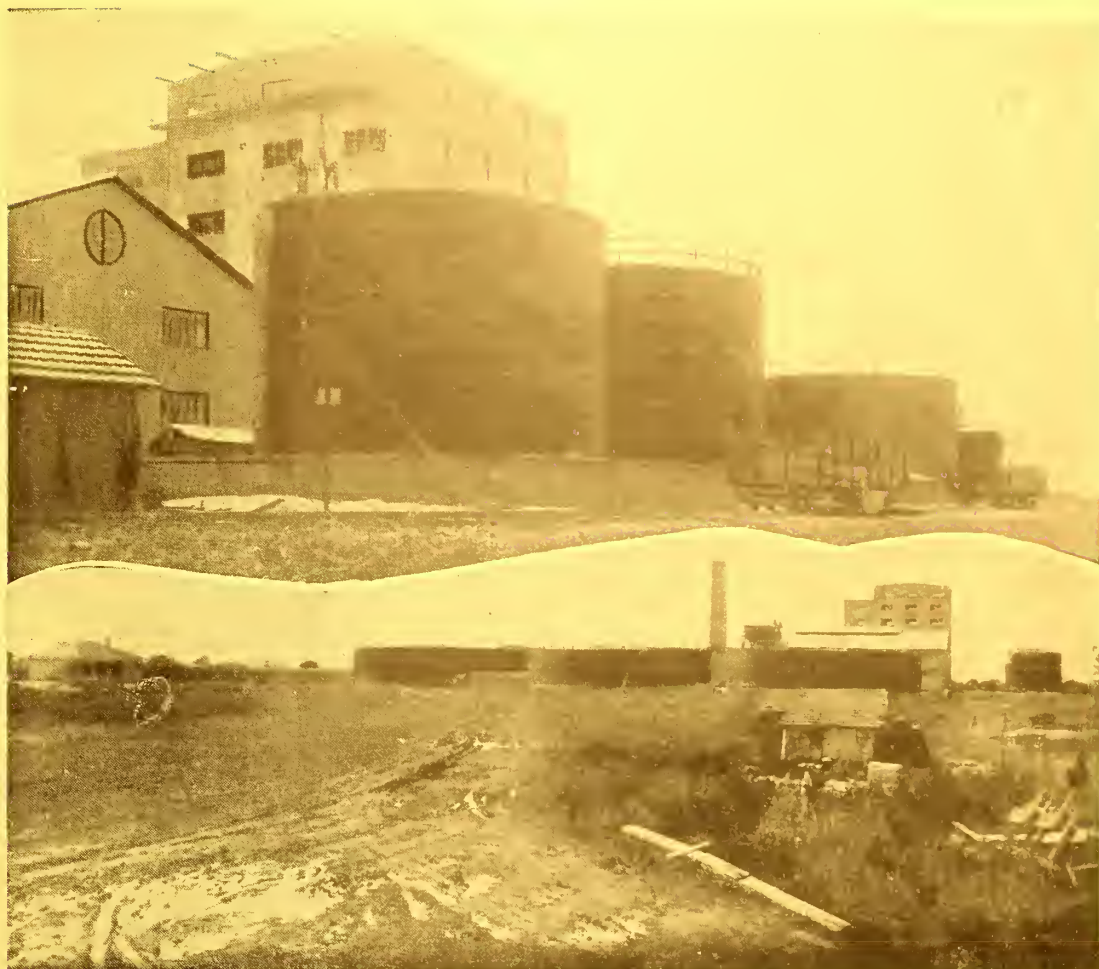
Dois outros aspectos da grande Distillaria de alcool anhidro: — Em cima, tanques de alcool e a linha ferrea; em baixo, os 3 tanques de melao, tanques de alcool e chaminé, ainda em construcção.
