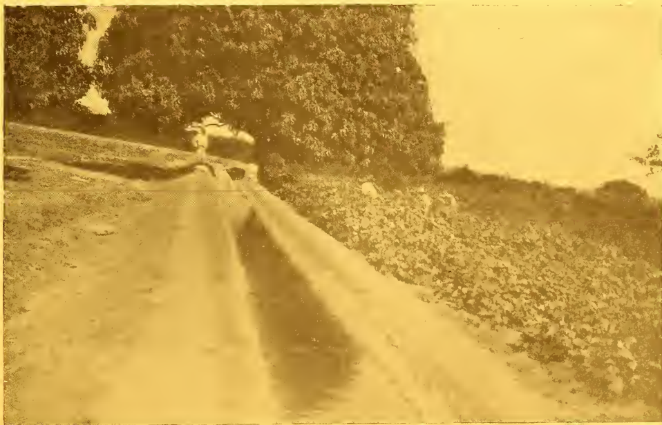
Irrigação por elevação mecânica em propriedade particular, no Icó, Estado do Ceará - Curva de um canal secundario.
