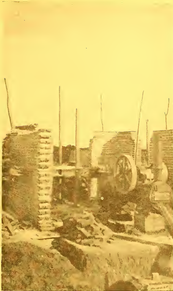
Montagem de bomba - locomovel e construção do respectivo abrigo para regadio com água subterranea nas varzeas do Iguatú, Estado do Ceará. Cooperação entre o Governo e os proprietarios locais e executada pelo autor em 1933
