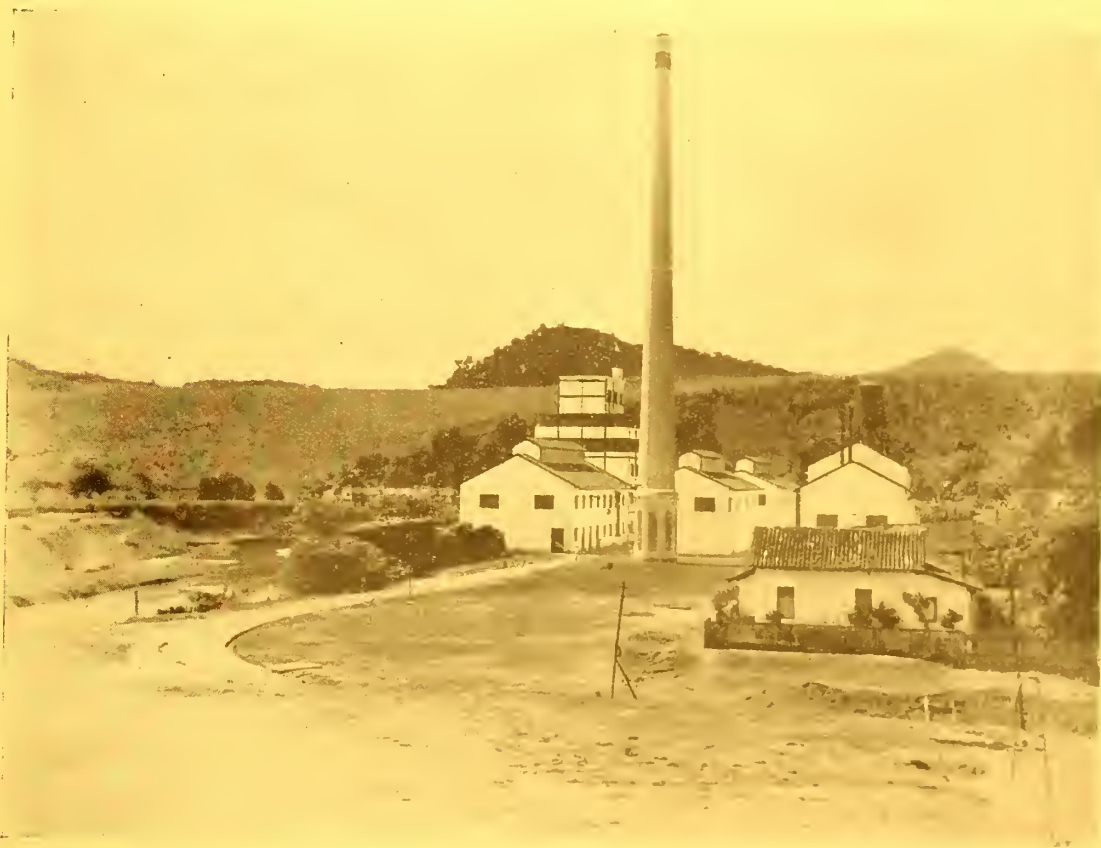
Perspectiva da nova distillaria de alcool anhidro que acaba de ser inaugurada na Usina Catende
