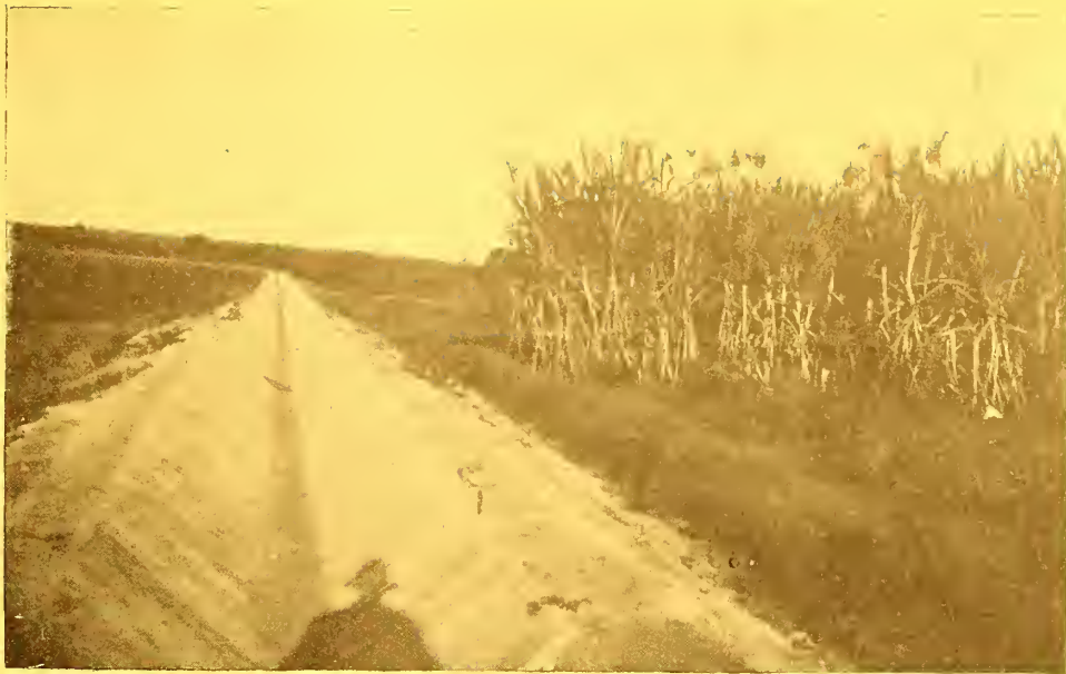
Irrigação por elevação mecânica no município cearense do Iguatú - Canal em terra revestido de alvenaria, prompto para funcionar.
