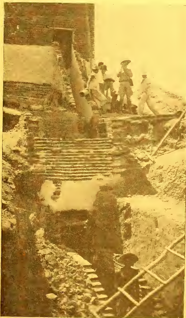
Irrigação mecânica de particulares no Nordeste. Conclusão do trabalho de ligação do motor e bomba centrífuga á margem do rio
