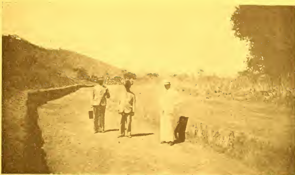
A abertura do sangradouro para novo caminho das aguas do Riacho São Pedro, por ocasião da visita do jornalista Democrito Rocha, na fase inicial da execução do plano
