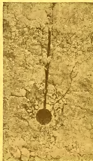
Dreno de 15 cent. a 60 cent. de profundidade.
