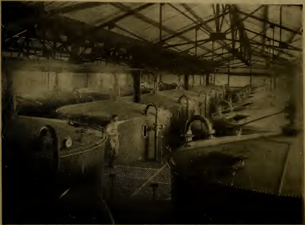
Aspecto interno das grandiosas installações da futura Distillaria de alcool anhidro levantada pelo I. A. A. em Campos - Sala de fermentação; com 24 dornas de 90 mil litros de capacidade, cada uma.
