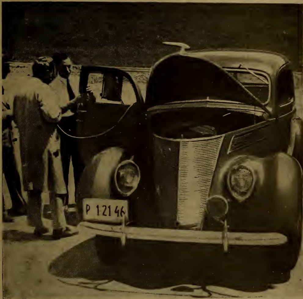
Flagrante da instalação do aparelho controlador "Zenith Mileage Tester" para a prova de consumo do carburante rosado, em um carro de passeio, gentilmente cedido para esse fim.
