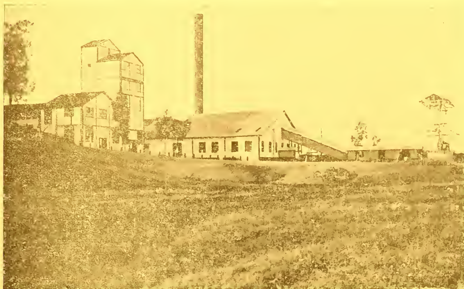
VISTA DA USINA DA DISTILLARIA DO OUTEIRO
