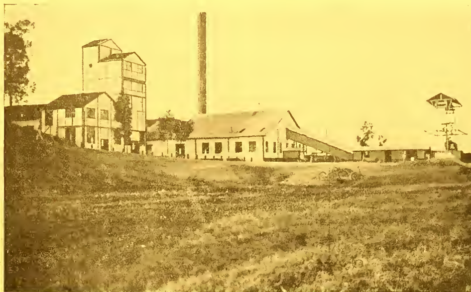
VISTA DA USINA DA DISTILLARIA DO OUTEIRO
