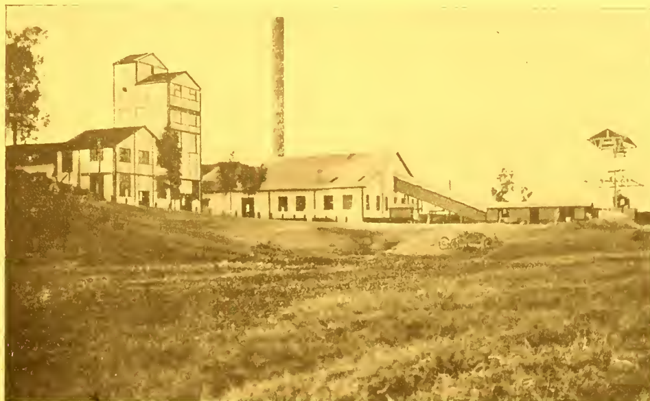
VISTA DA USINA DA DISTILLARIA DO OUTEIRO
