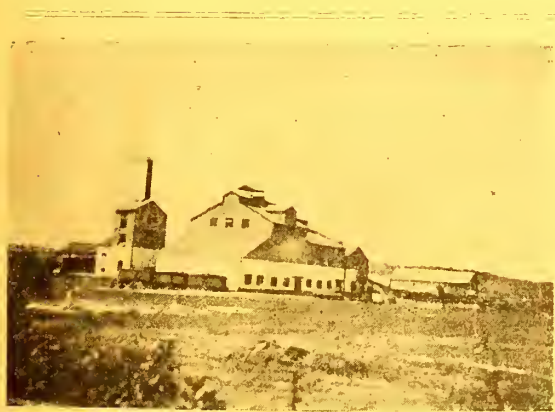
Usina Carapébús — Macahé — Rio de Janeiro
