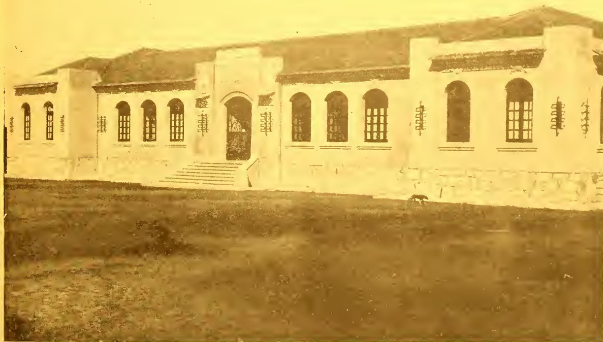
Fachada principal da nova Estação Experimental de Canna de Açucar
