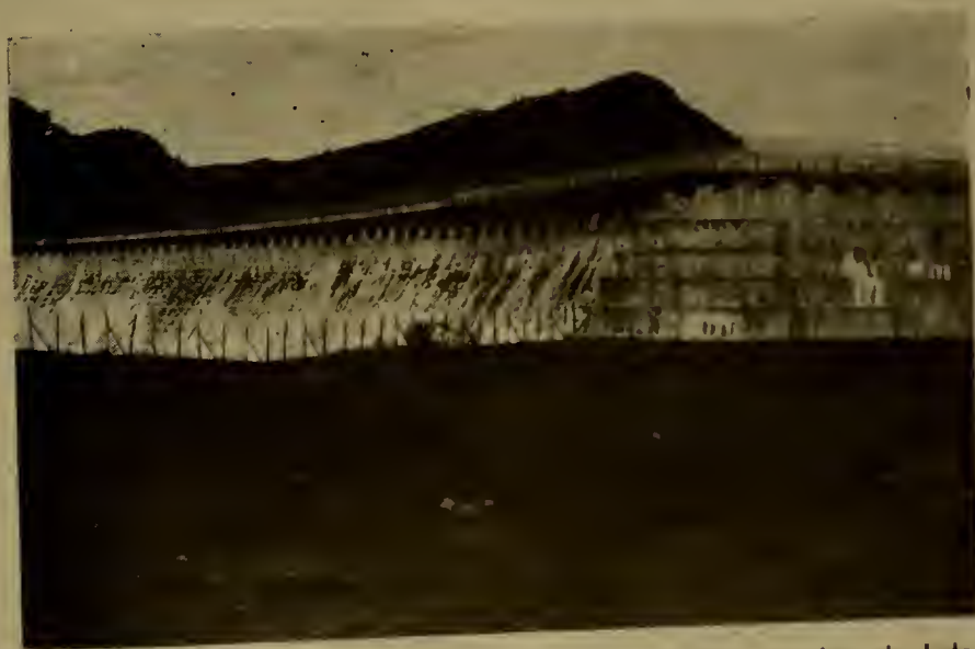
A barragem do "Acarape do Meio", feita sobre o rio Pacoty, vista do lado Jusante
