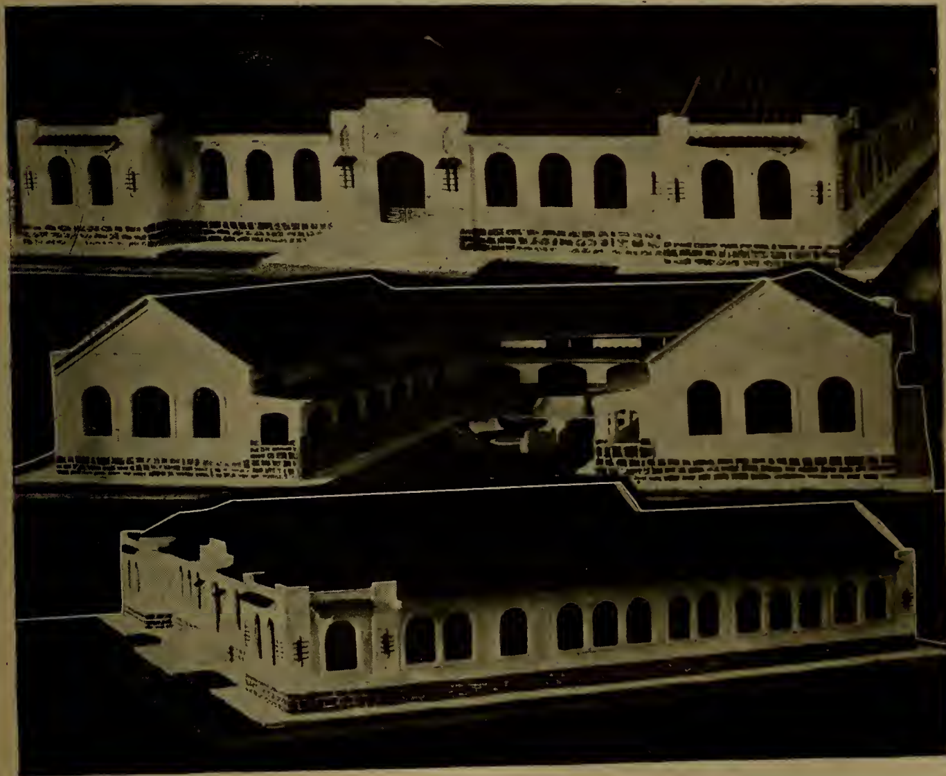
Tres aspectos da nova Estação Experimental -- De cima para baixo: a frente do edificio; os fundos, vendo-se o pateo interno, e uma vista lateral
