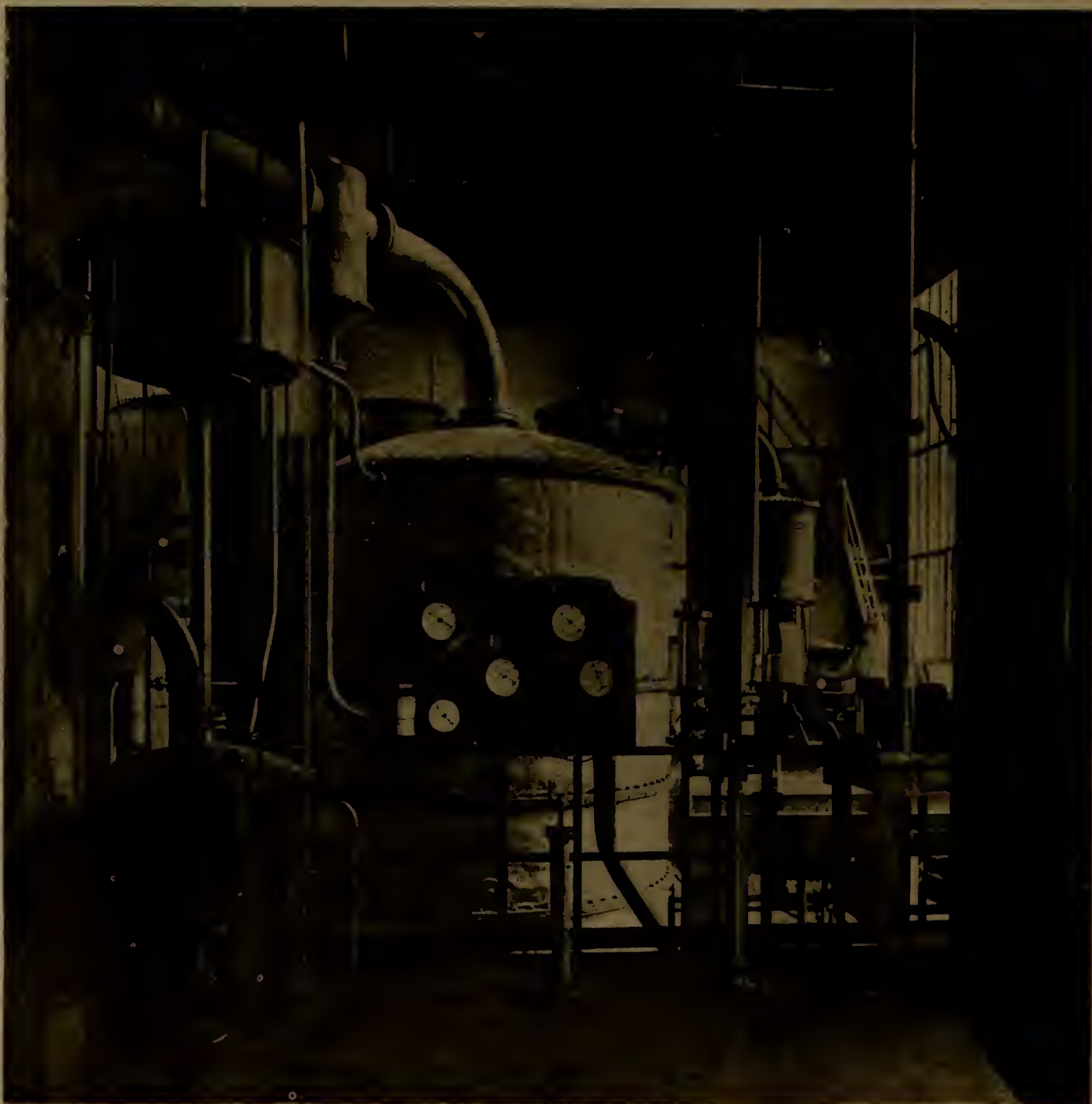
Appareilho 4.a Technica da Usina Delloye, de Iwuy (Nord) -- Construido pelos Estabelecimentos Barbet -- Produção: 35.000 litros em 24 horas
