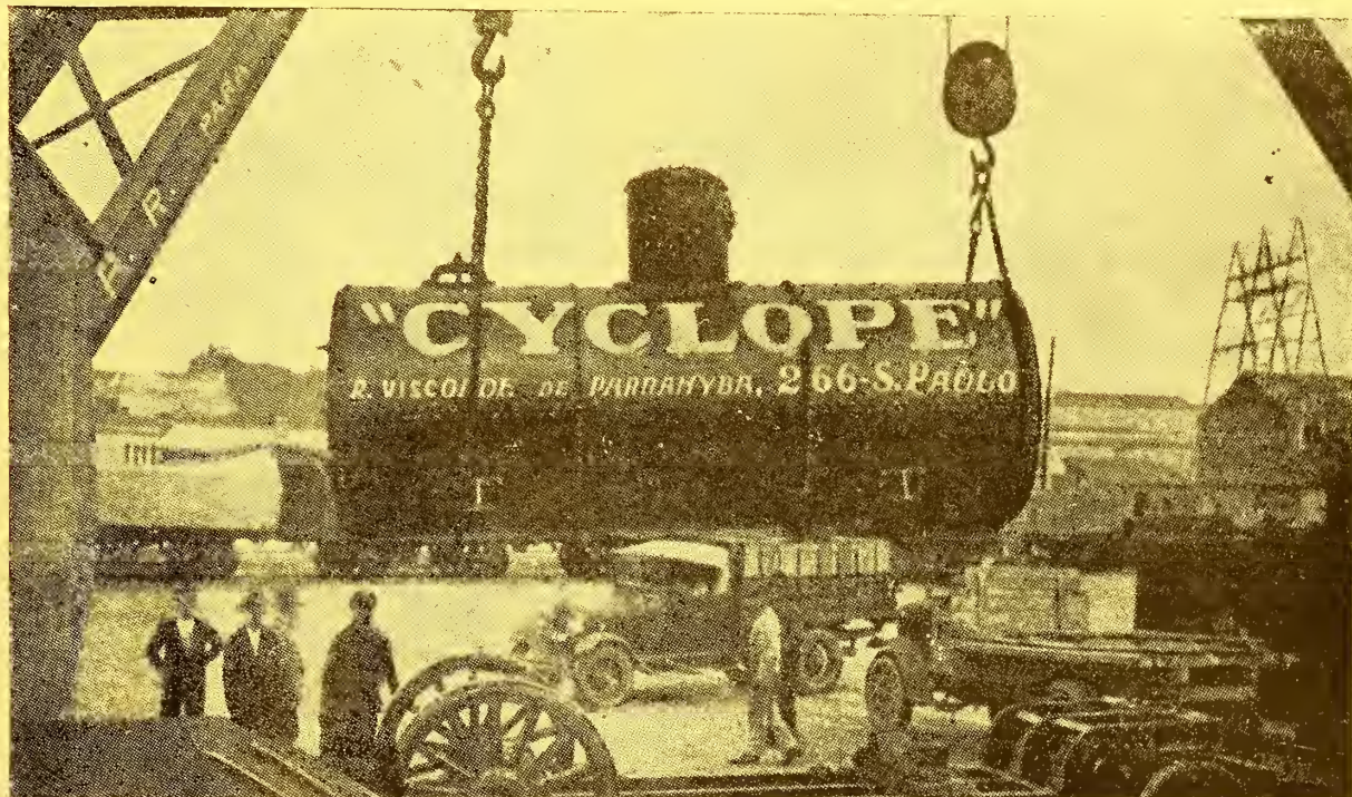
Caldeira multitubular "CYCLOPE" fornecida á Cia. Estrada de Ferro e Agricola Santa Barbara
