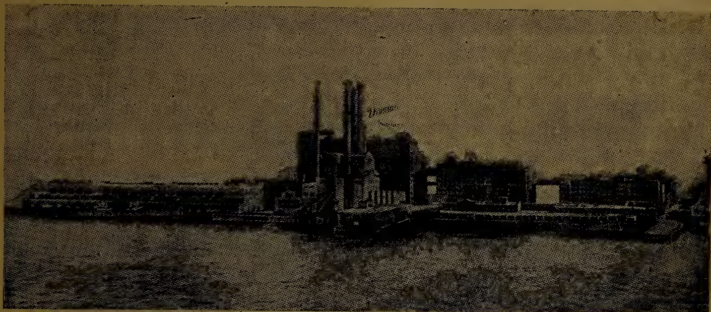
O nome de Brooklyn foi por muitos anos sinonimo de Refinação de Açucar. — A Usina que figura na presente estampa pertence á American Sugar Refining Comp. Fica situada naquela cidade americana e foi construida em 1865, sofrendo, em 1926, uma remodelação completa dentro dos moldes da arquitetura moderna.
