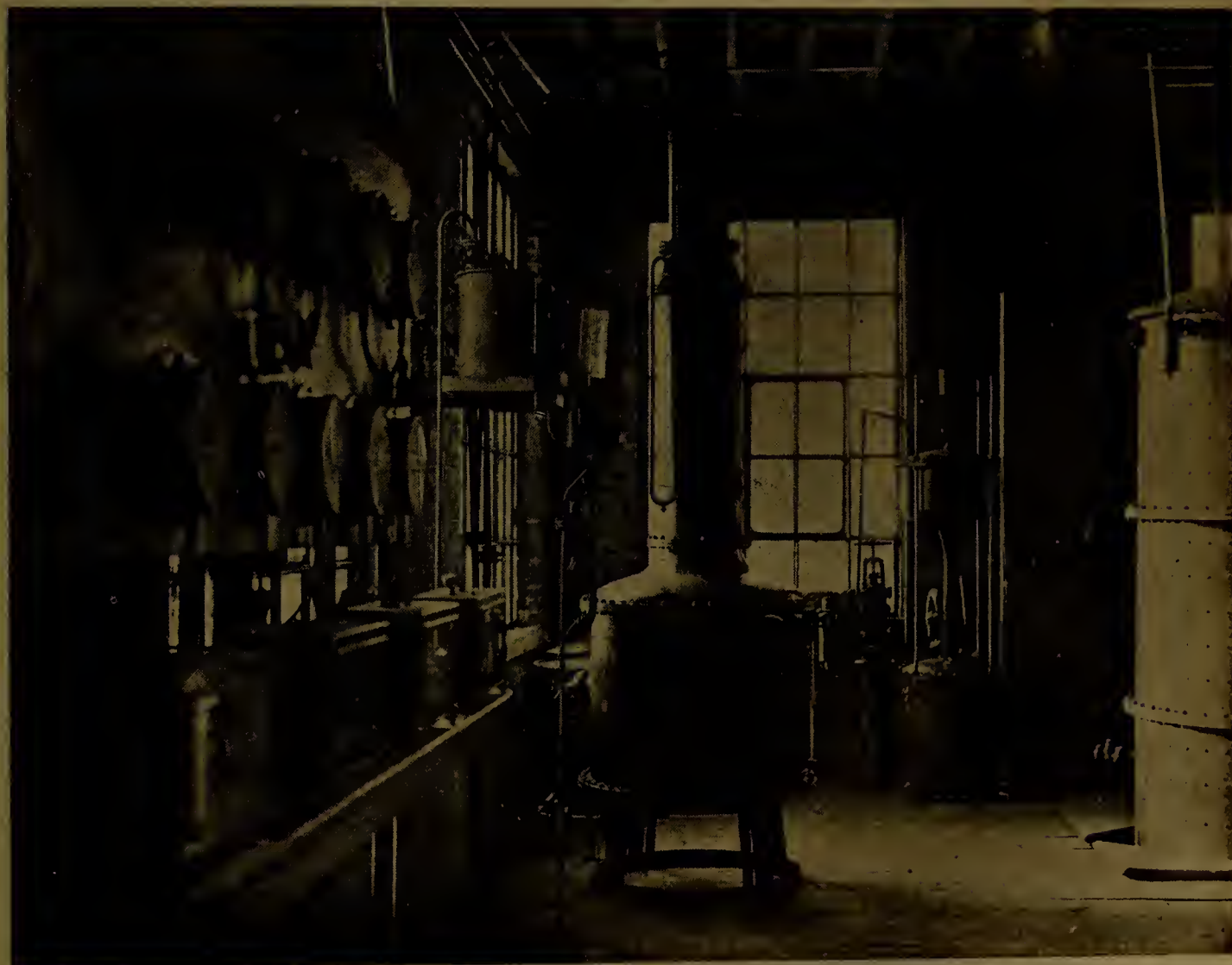
Posto de controle de uma instalação de desidratação azeotrópica.
