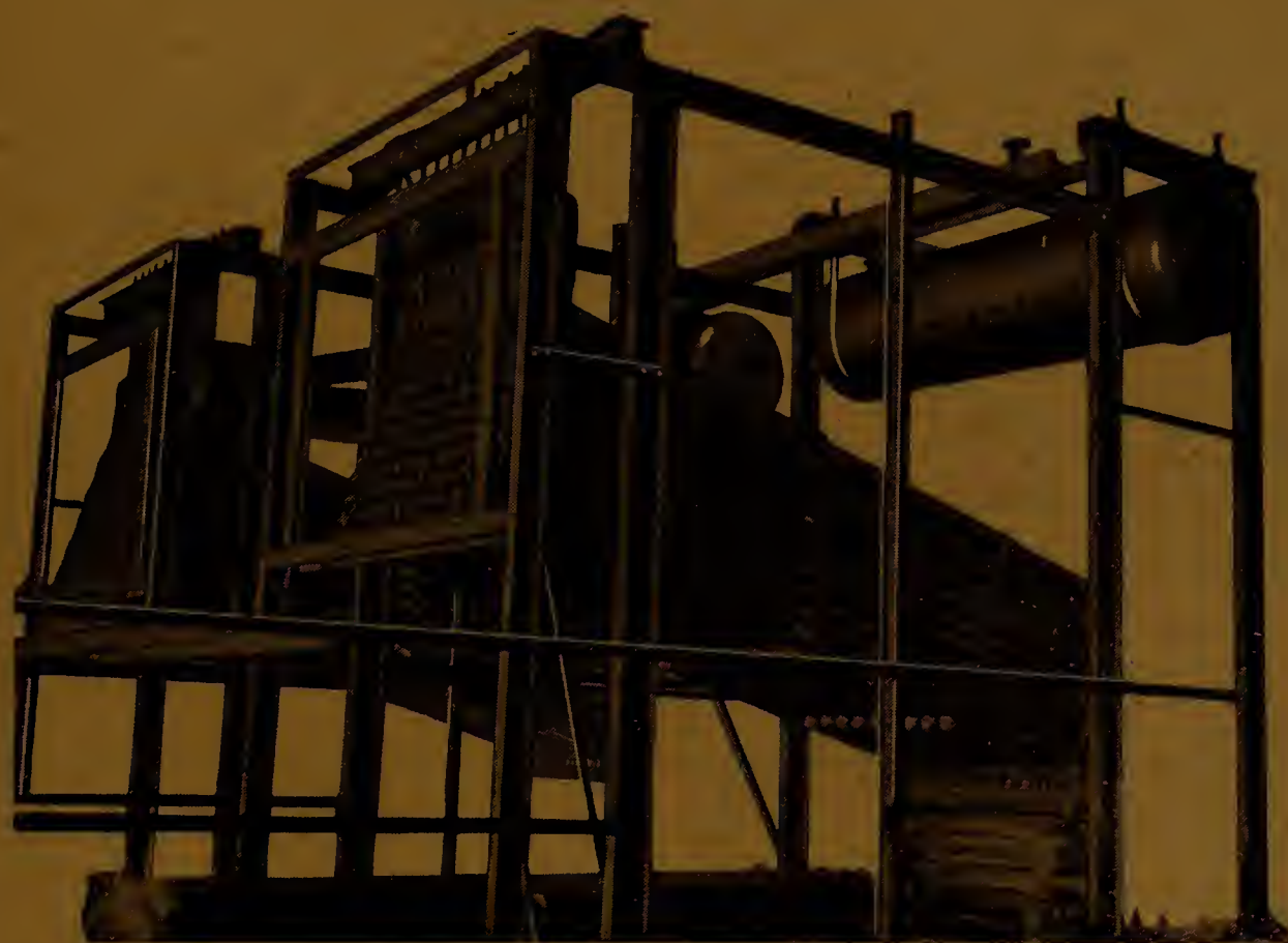
Caldeira dupla, de câmaras seccionais, em montagem. Cada 250 m 2 SA. — Pressão de prova 300 Lbs.
