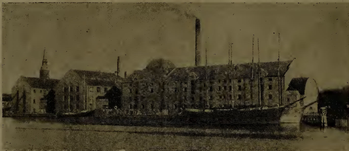
A refinaria "Phoenix", em Copenhague, depois de reconstruída
