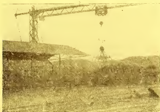
Descarregamento mecânico da cana na Usina Catende. O guindaste rotativo actua como subsidiário.
