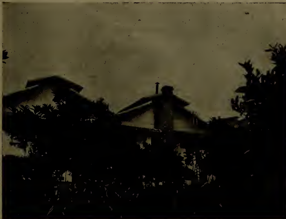
Esta chaminé pertenceu ao famoso e grande Engenho do Retiro, a fábrica setecentista situada no alto vale do Sarapuí, ao tempo do Marquês do Lavradio tratado como Rio do Retiro. Hoje, reconstruída e encurtada, serve ao hospital dos operários das tecelagens do Bangu, sendo que a clínica aproveitou galpões da sólida construção açucareira que entrou êste século em plena atividade (Foto Affonso Varzea)
