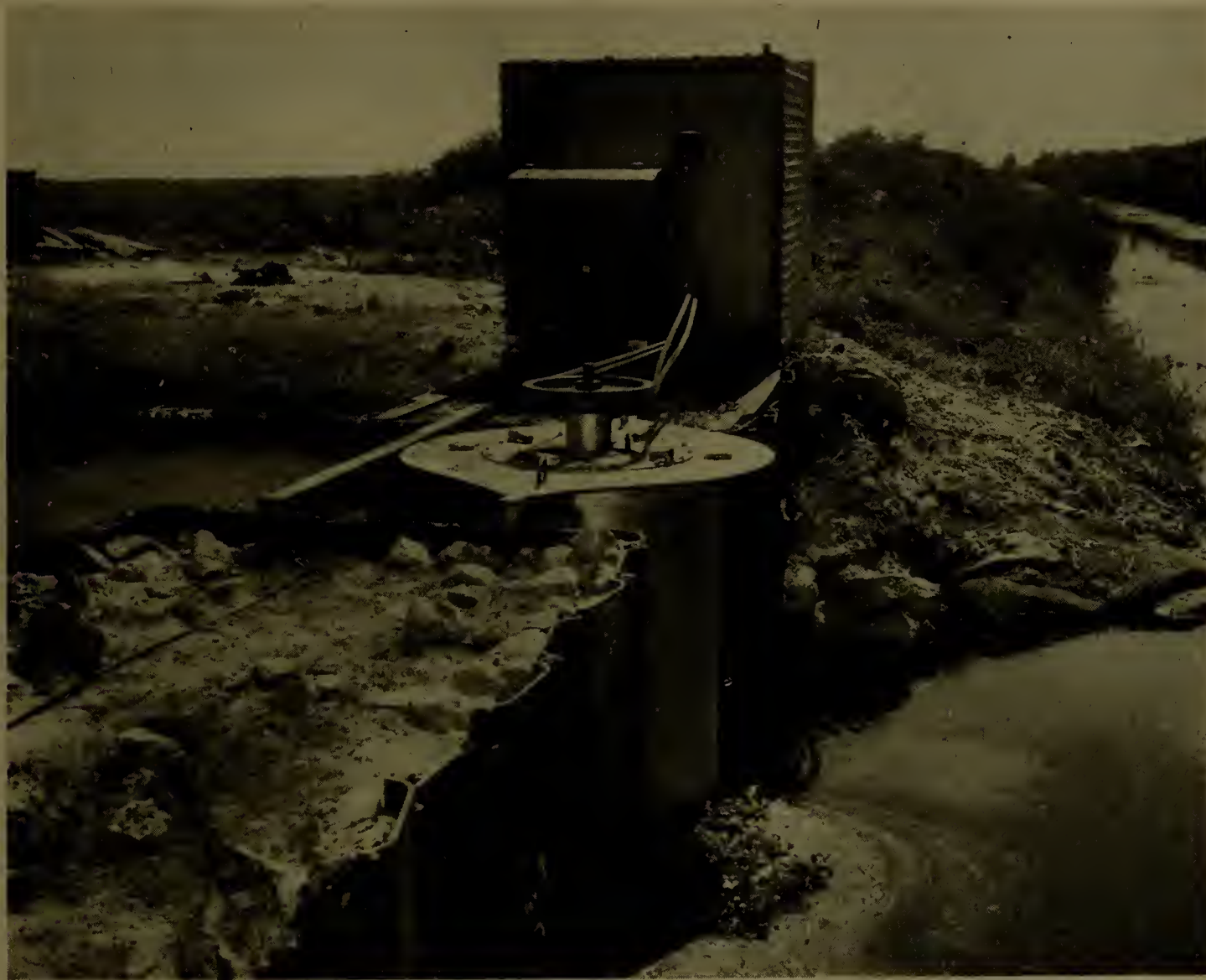
Um dos tipos de comporta usada no serviço de contrôle de águas
