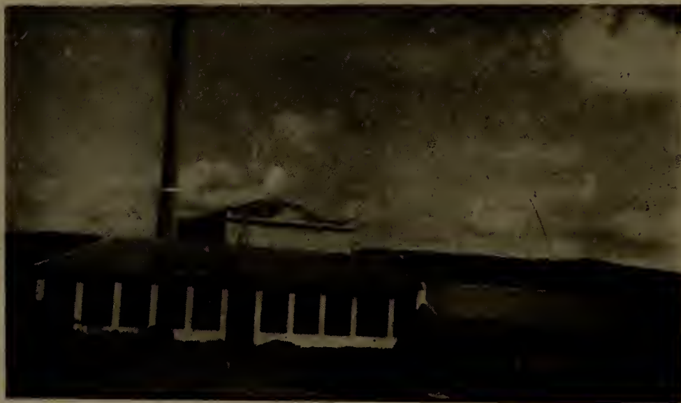
Outro aspecto da usina Caeté vendo-se a casa de máquinas e esteira
