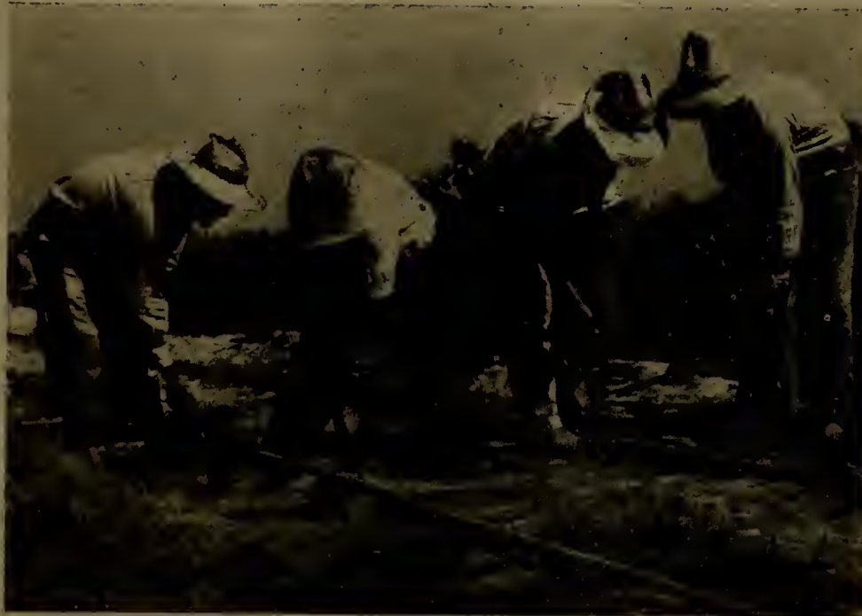
Trabalhadores reparando os trilhos da ferrovia de uma usina nortista
