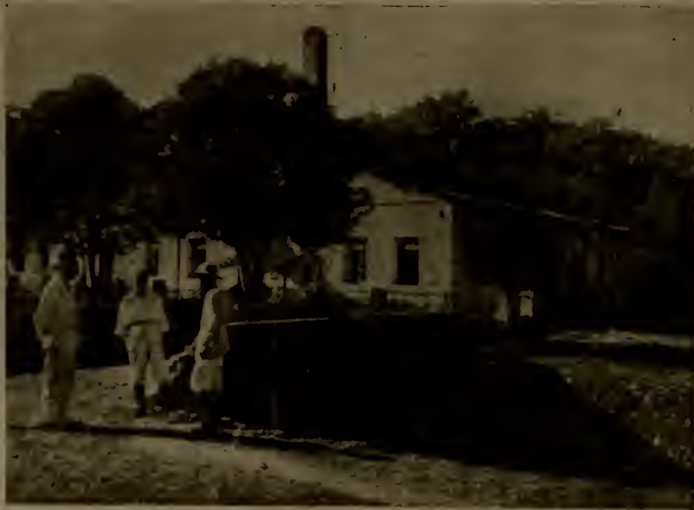
Como êsses, dezenas de antigos engenhos são ainda encontrados no Recôncavo sustentando penosamente uma longa tradição açucareira
