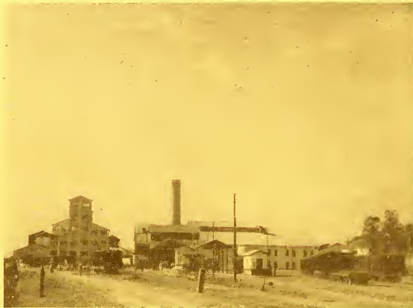
Usina São José, em Campos
