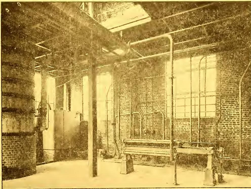
INSTALAÇÃO D'ECHAUDAGE A.P.V. PARA PASTEURIZAÇÃO DE CALDO DE CANA
