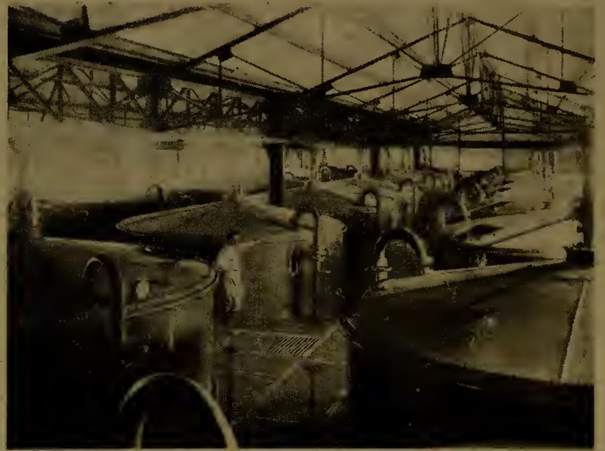
Distilaria Central do Estado do Rio do Instituto do Açucar e do Alcool (Sala de fermentação)
