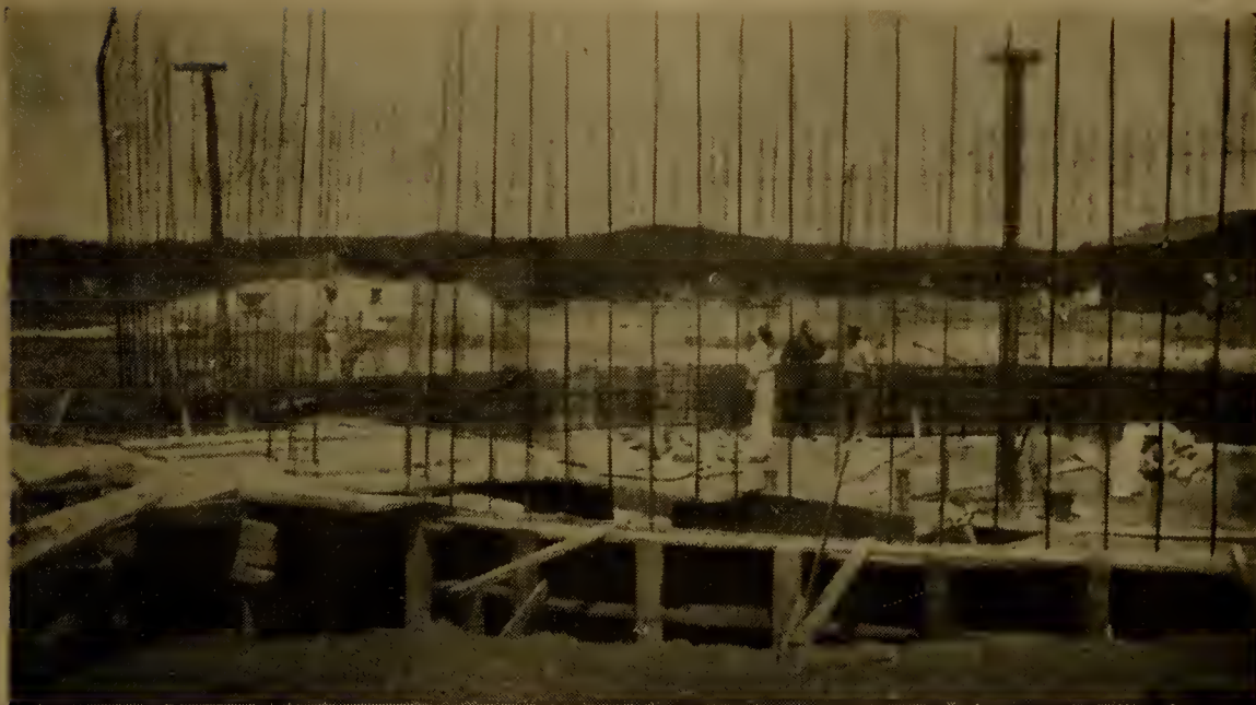
Distilaria Central de Pernambuco - Tanque para melaço, com as fundações prontas.
