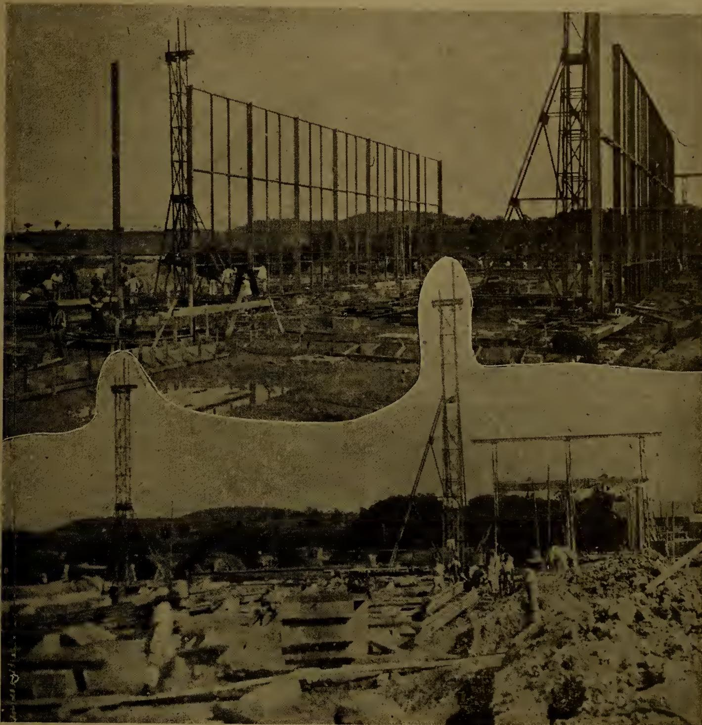
Dois aspectos das obras, vendo-se, em cima, as duas torres para levantamento das colunas do edificio de fermentação
