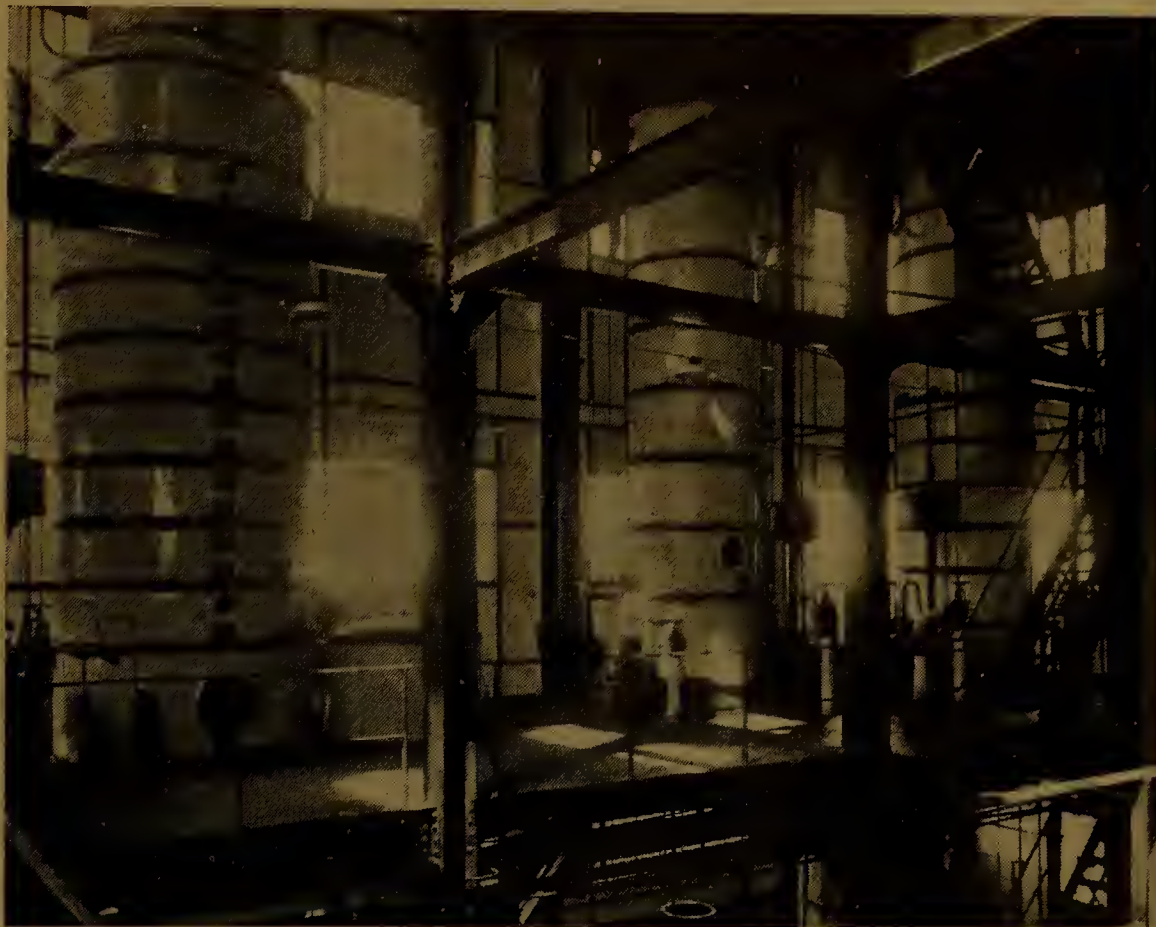
Um dos aparelhos de distilação-retificação-deshidratação para produzir 600 hectolitros de alcool em 24 horas
