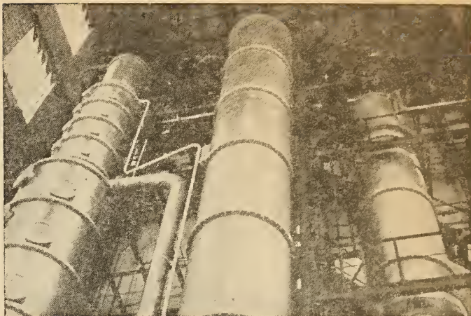
DESTILARIA COM CAPACIDADE 40.000 LITROS. ÁLCOOL ANIDRO SISTEMA BENZOL - USINA SÃO JOÃO - CAMPOS - ESTADO DO RIO
