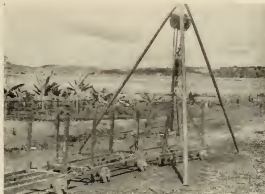
Material empregado atualmente para pesagem das canas dos experimentos: Tripé, talha, balança de suspensão e 3 carretas
