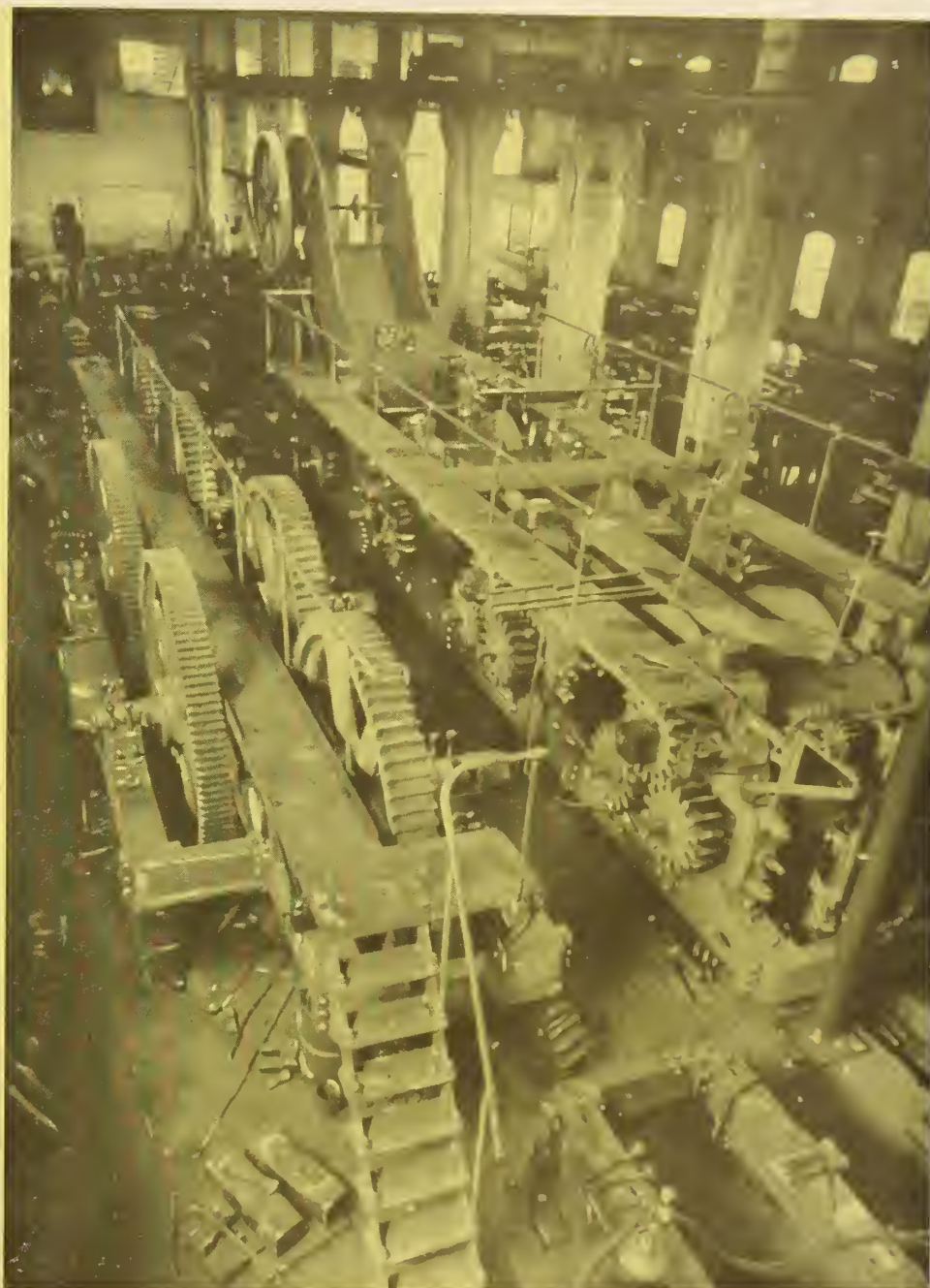
Moenda "DEDINI" 24 x 48", 12 rolos, para a Usina Ouricuri, em estágio final de montagem. Principio abril 1949
