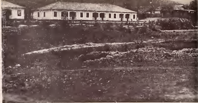
Algumas das casas de residencia para operarios da Usina Santa Theresinha
