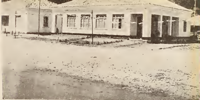
Residencia de auxiliares da Usina Santa Theresinha
