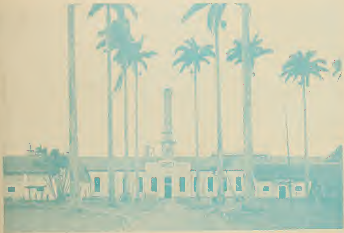
Fachada da actual Usina de Quissaman
