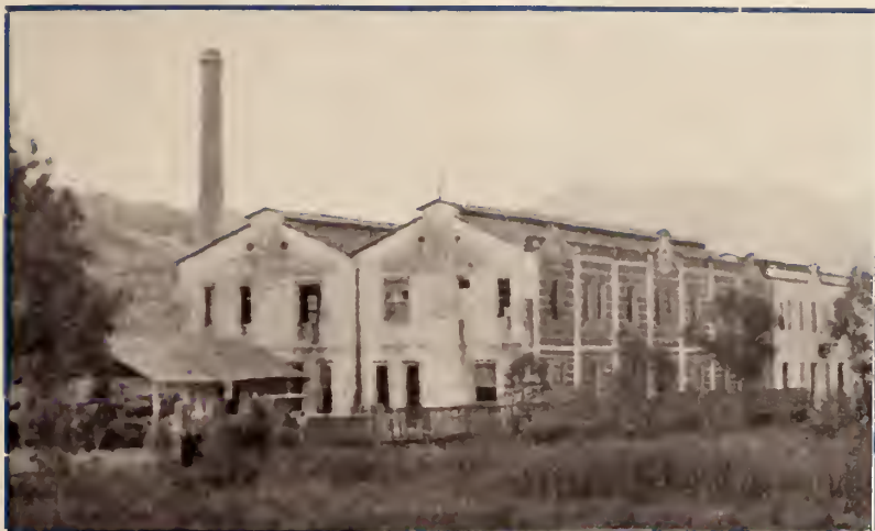
VISTA EXTERNA DO EDIFÍCIO DA USINA
