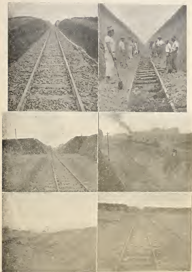
Tongente de 3 Km. no trecho em construção entre Chorqueodos S. João e S. Luiz
