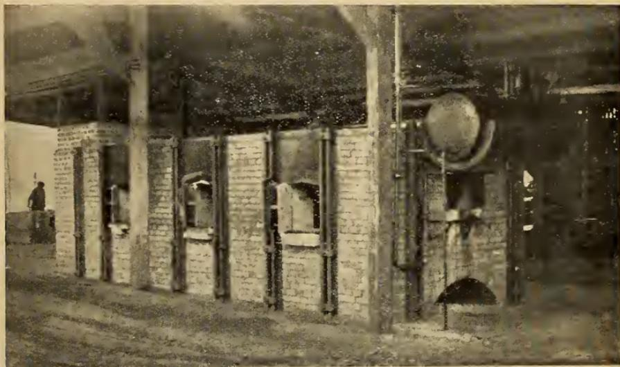
Forno para aquecimento dos pacotes destinados à laminagem, construído nas oficinas de Santa Maria.
