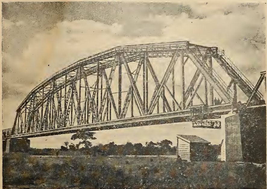
Ponte sobre o rio Caf — Variante Barreto - Gravataí — vão de 152,04m.
