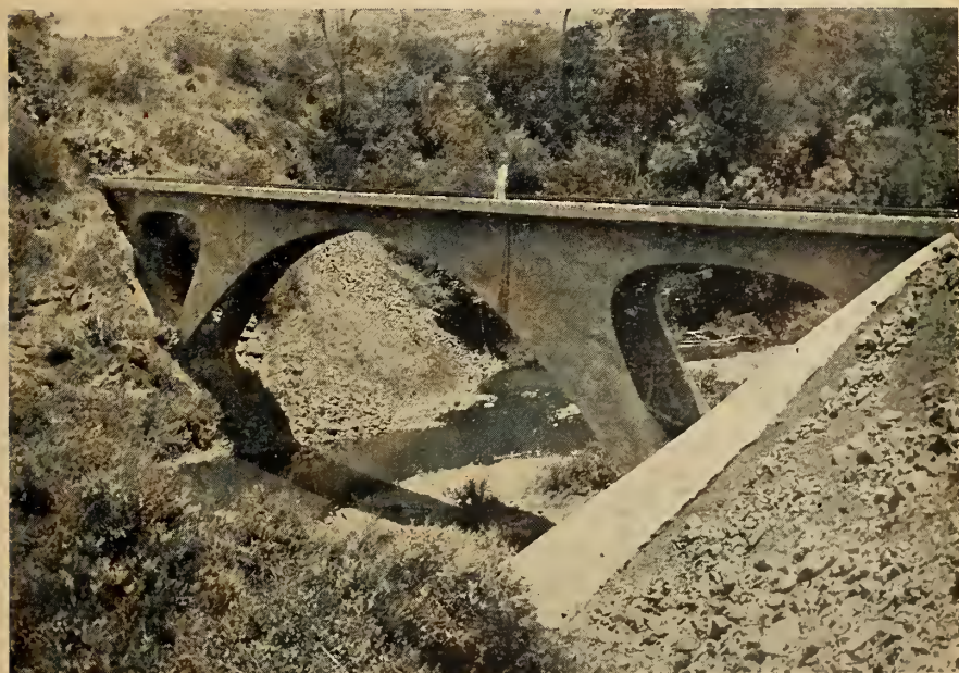
Pontes no ramal de Dilermando de Aguiar — S. Borja — Construídas, pelo 1.º Batalhão Ferroviário.
