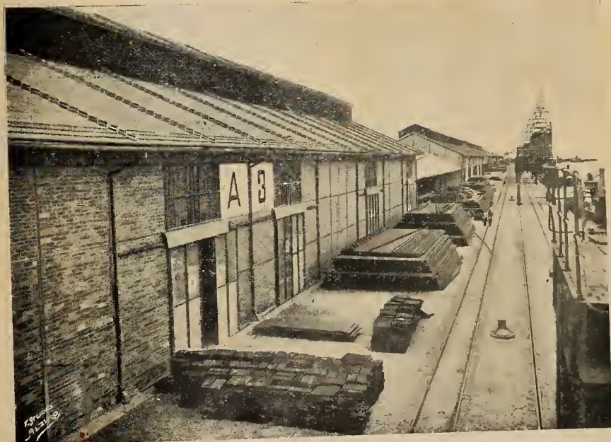
Trilhos e acessórios para a linha, depositados no porto de Rio Grande.
