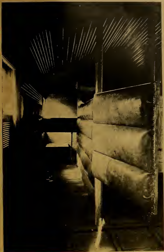
Detalhe do interior do vagão 1451, construído nas Oficinas do Kilometro Tres, para transporte de animais finos. Báia e mangedoura.
