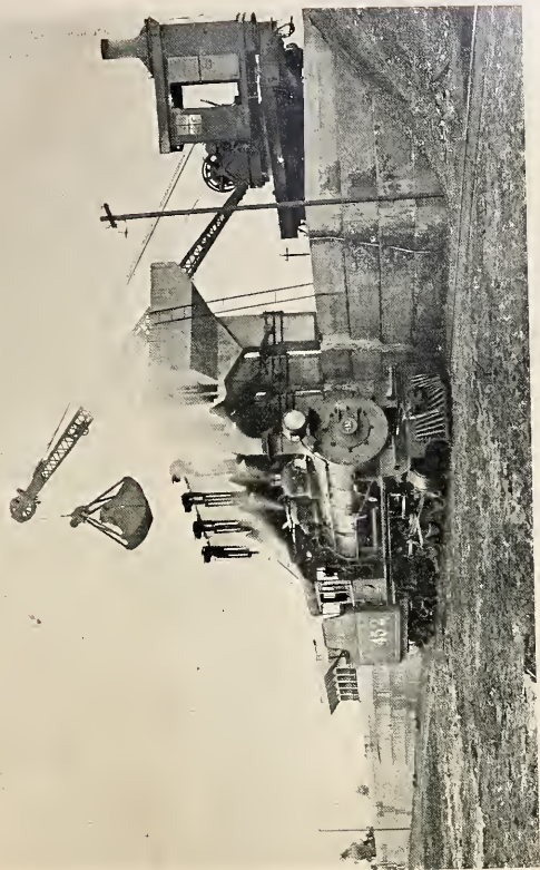
Carvoeira do Deposito de Cacequi — Vista geral dos dois grupos de silos, vendo-se no primeiro grupo, uma locomotiva se abastecendo de carvão nacional, bem como o guindaste de fornecimento aos silos
