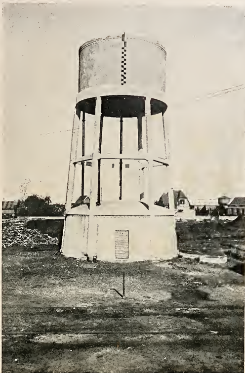
Estação de Rio Grande Reservatório de concreto armado, com capacidade de 200 metros cúbicos
