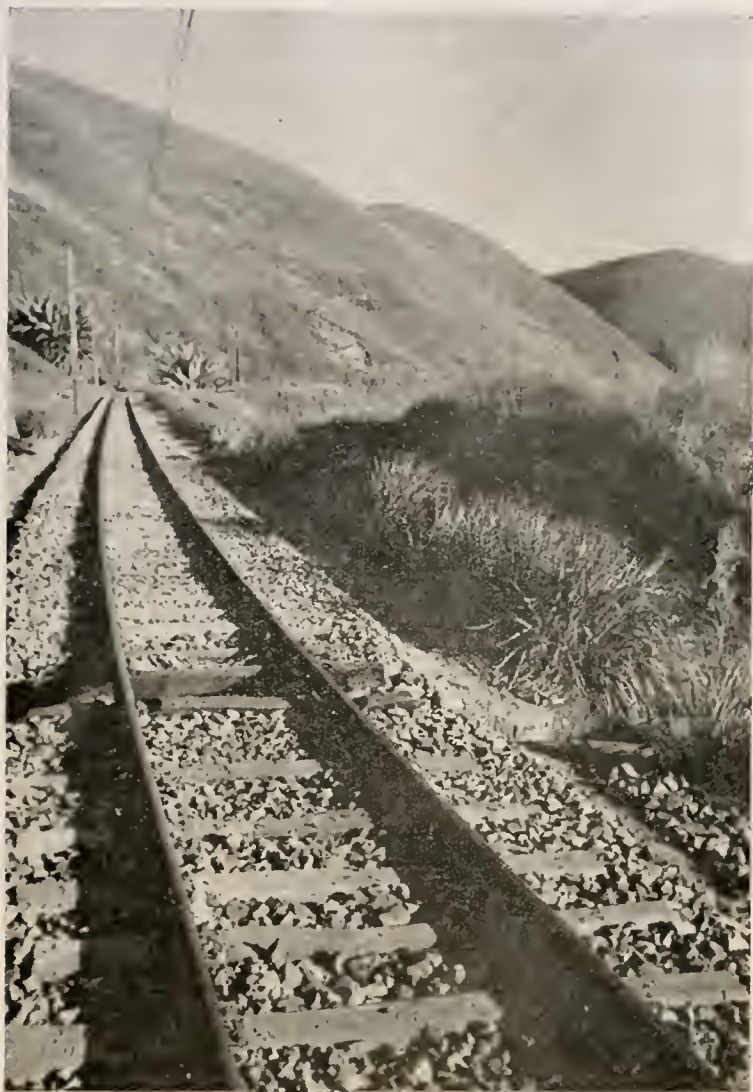
Trecho de linha, na Serra da Mantiqueira, lastrado com pedra britada
