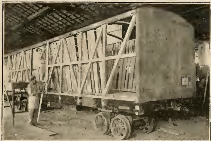
Vagão de mercadorias, em reparação nas Oficinas de Divinópolis
