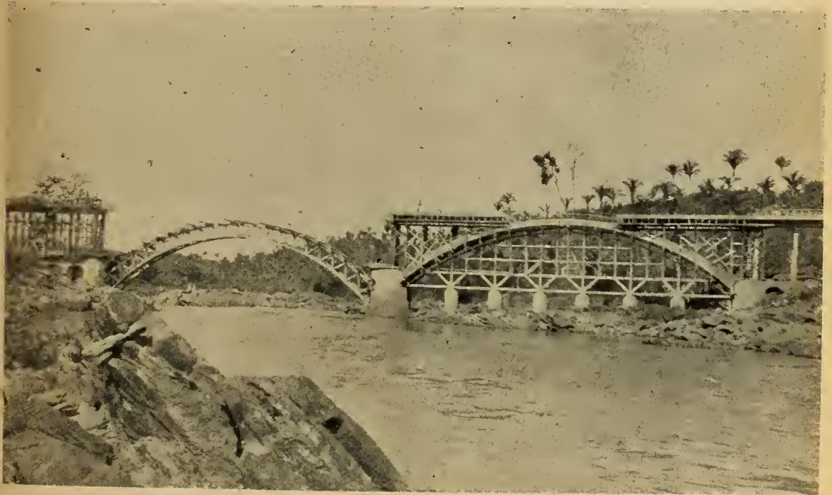
Duas fases da construção da ponte sobre o Rio Paranaíba
