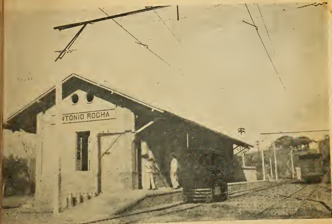
A Estação de Antonio Rocha, do trecho da Eletriificação ora em construção entre Barra Mansa e Angra dos Reis
