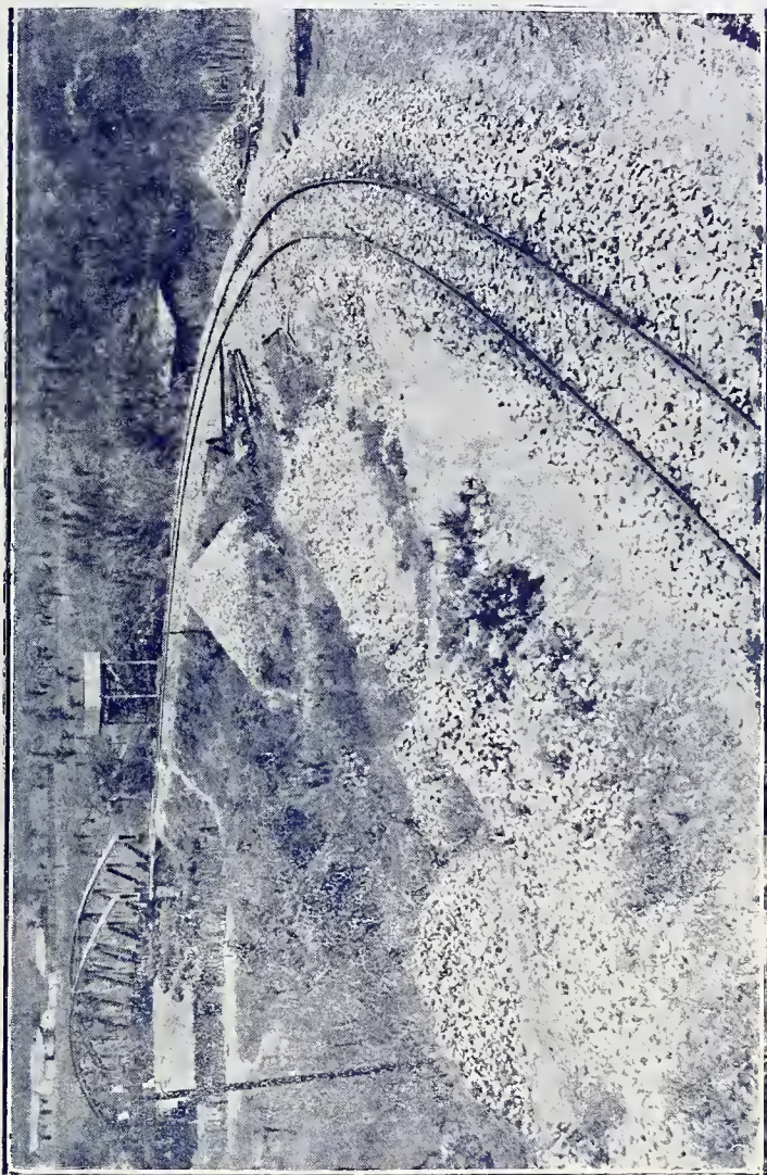
Aspecto do empedramento do trecho Bomfim-Barra de Mundo Novo, vendo-se os depósitos de brita quebrada a mão.
