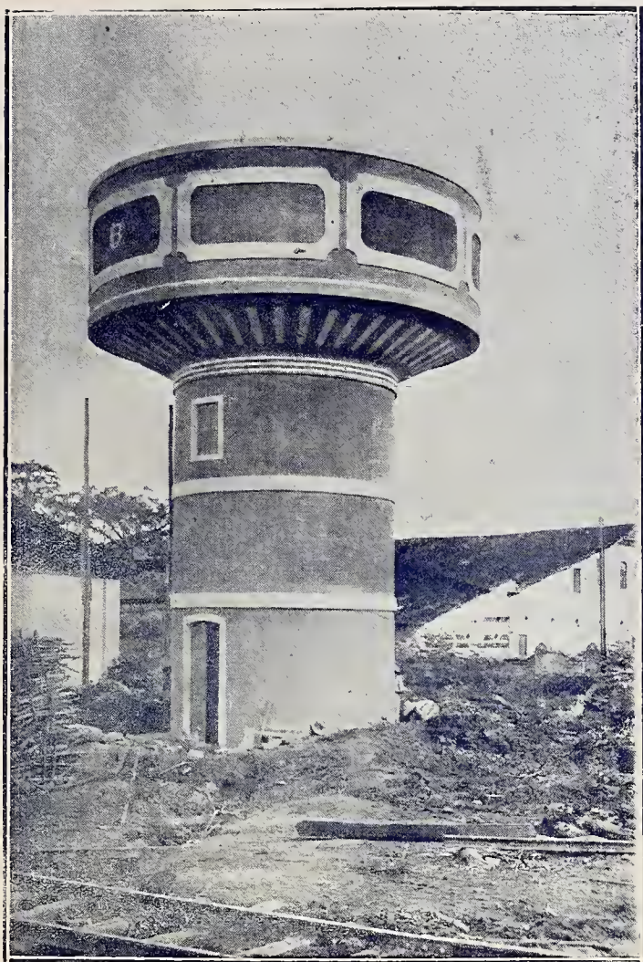
Fotografia de uma caixa d'água em concreto armado, de 120.000 litros de capacidade, recentemente construída em S. Amaro. A água, que vem de 2 kms. de distância, em tubulação de ferro fundido de 4" de diâmetro, é recalçada do rio Sergi, onde se construiu, também, uma casa de bombas, com duas possantes centrífugas.
