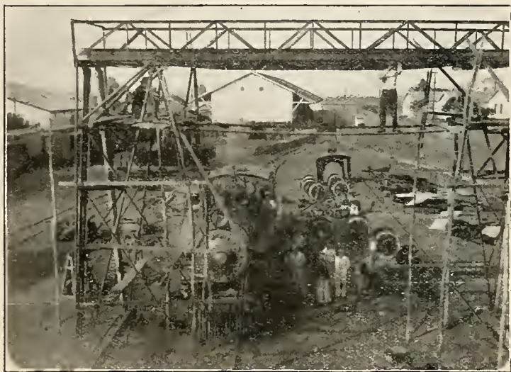
Construção de uma ponte rolante para montagem do material recebido
