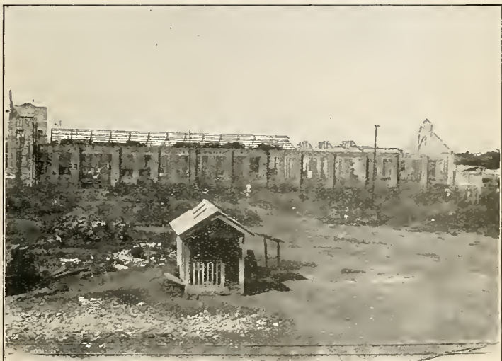
Novas Oficinas de Araguari — Vista lateral da construção
