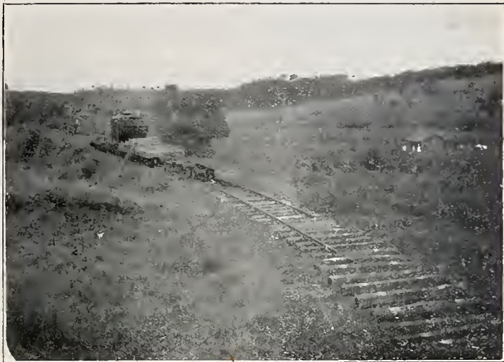
Prolongamento — Assentamento da linha
