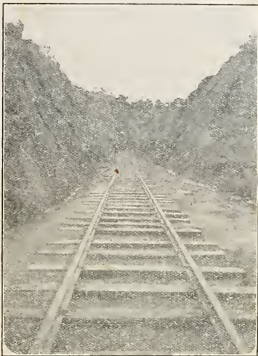
Prolongamento — Assentamento da Linha
