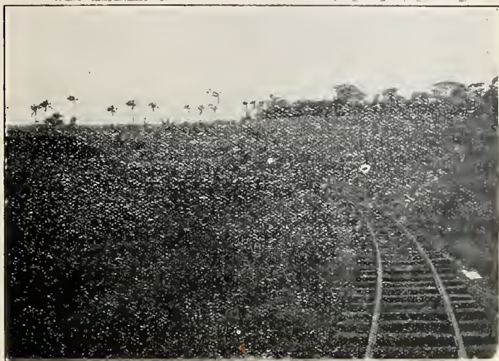
Prolongamento — Assentamento da linha
