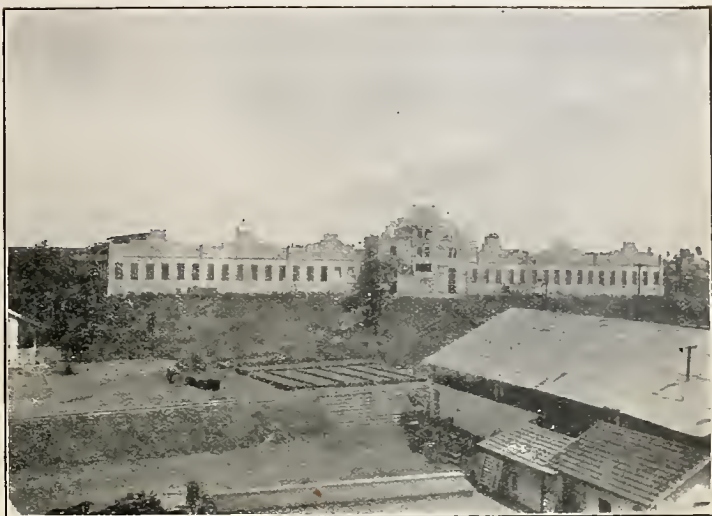
Novas Oficinas de Araguari — Fachada principal
