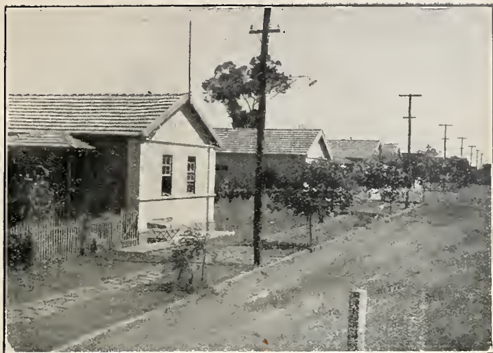
Esplanada de Araguari — Linha de alta tensão para as oficinas
