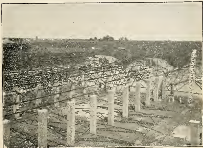
Novas Oficinas de Araguari — Cobertura metálica
