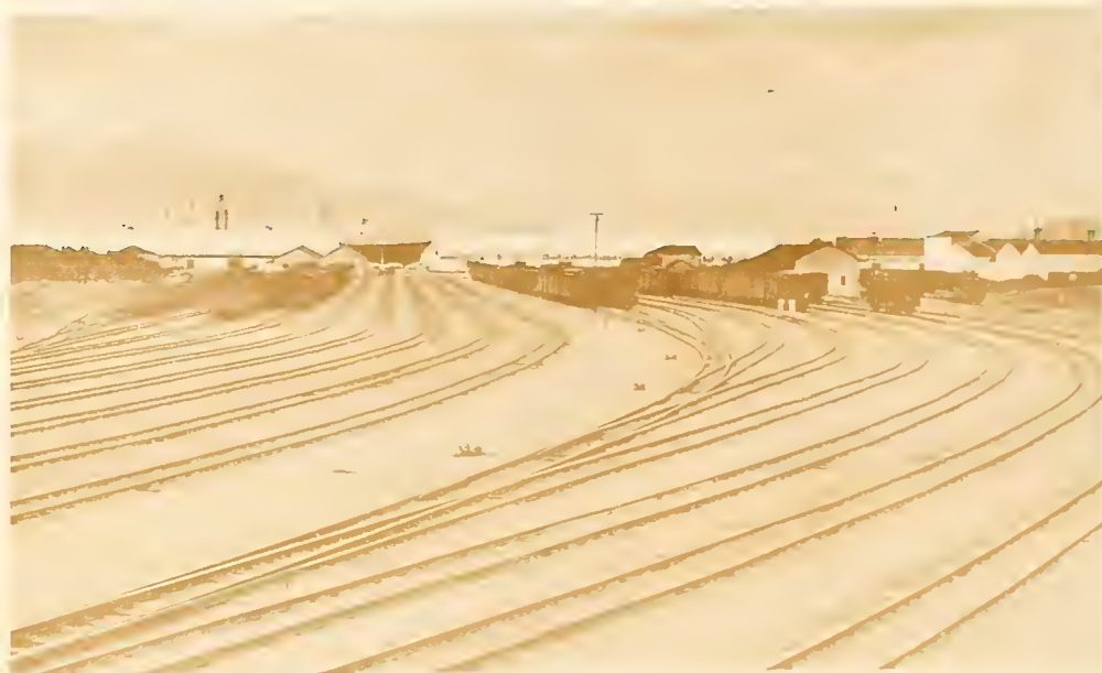
Pátio, de 20 linhas, no Pôrto de Paranaguá — RVPSC
