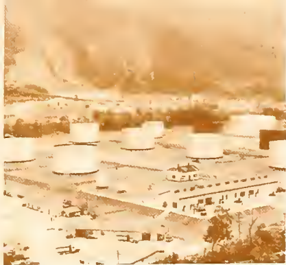
Montagem dos tanques em Cubatão — EFSJ
