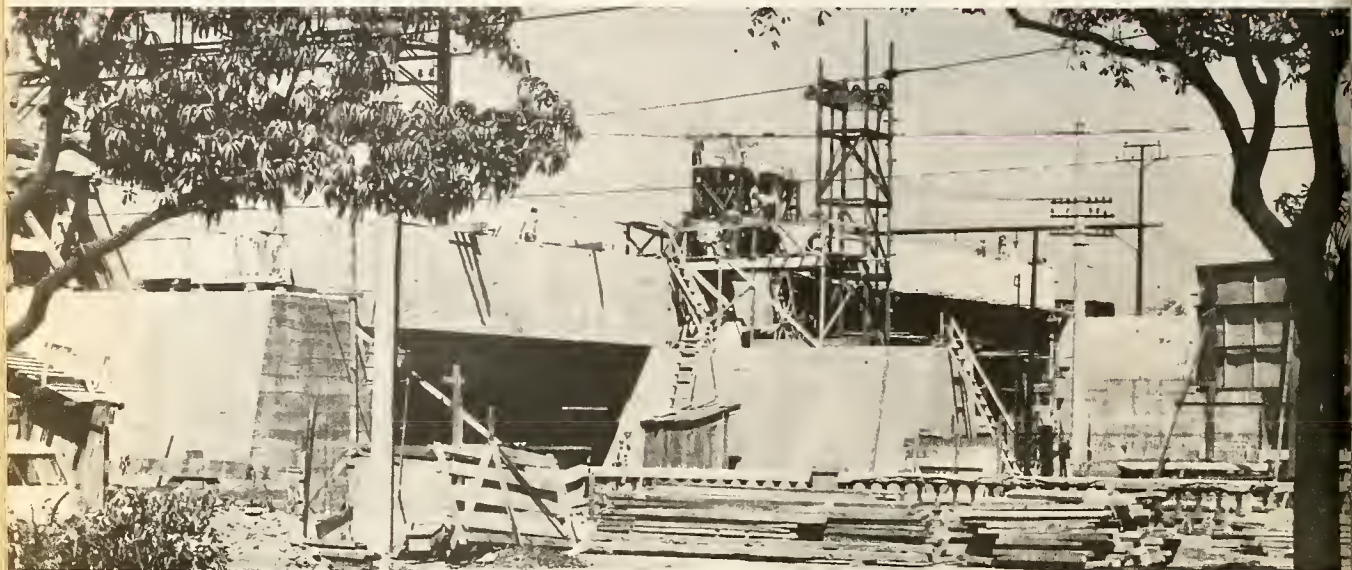
EFCB - Viaduto no Estado da Guanabara
