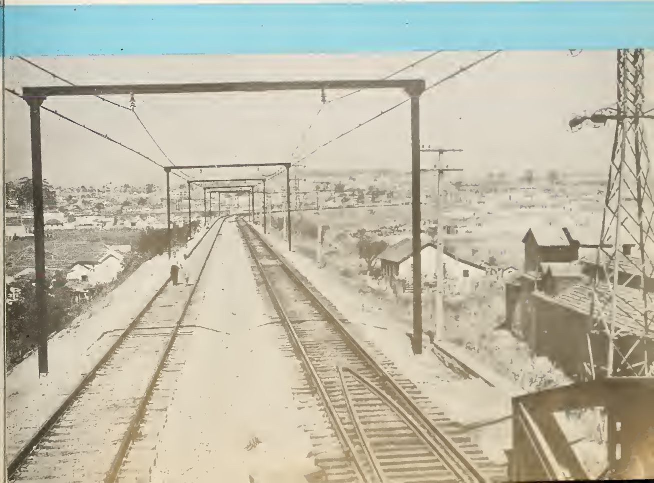
Trecho de linhas suburbanas reformadas em 1959.
