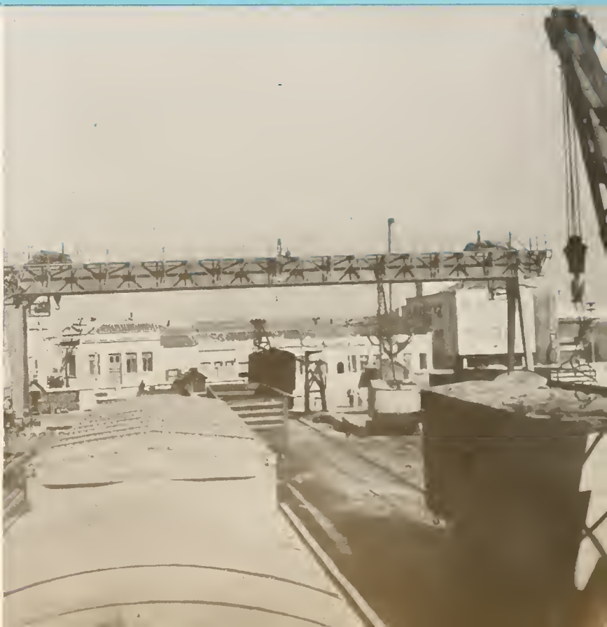
Ponte rolante em operação num pátio de manobras.
