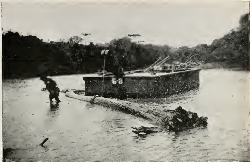
Paraná — Rio Iguaçu — Serviço de desobstrução do leito
