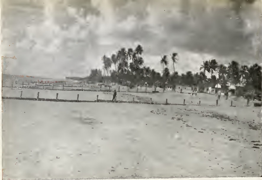
Um trecho da Praia Formosa, vendo-se o avanço da praia com a construção dos espições
