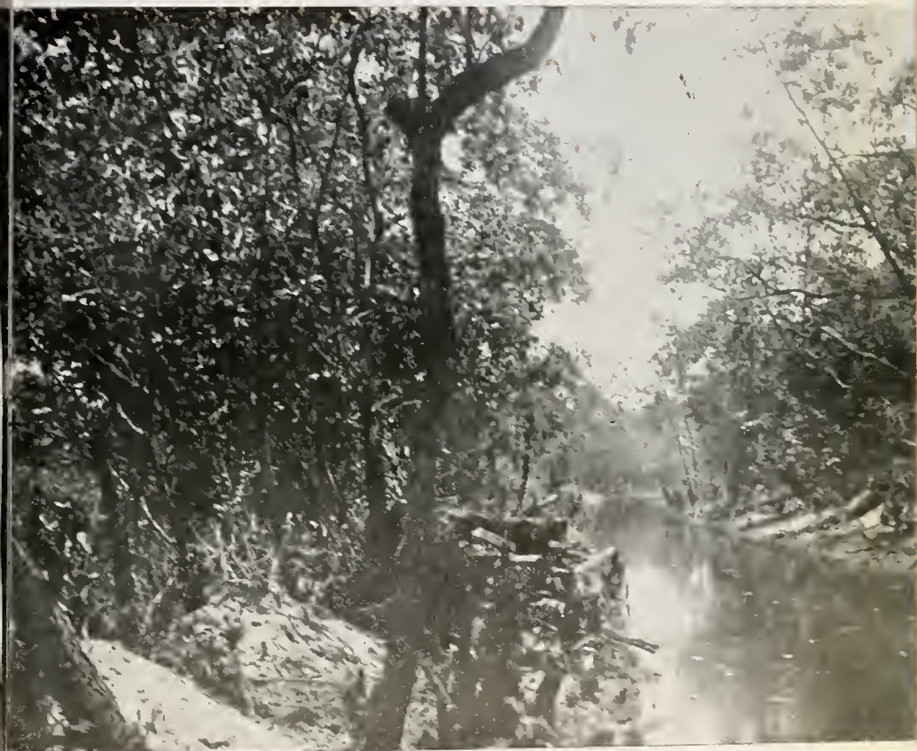
Estado do Espírito Santo — trecho da vala do rio Itaúna, já desobstruído
