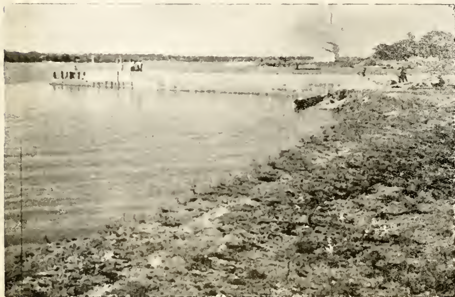
Pôrto de Belmonte — Espigão "E-6" visto de montante
