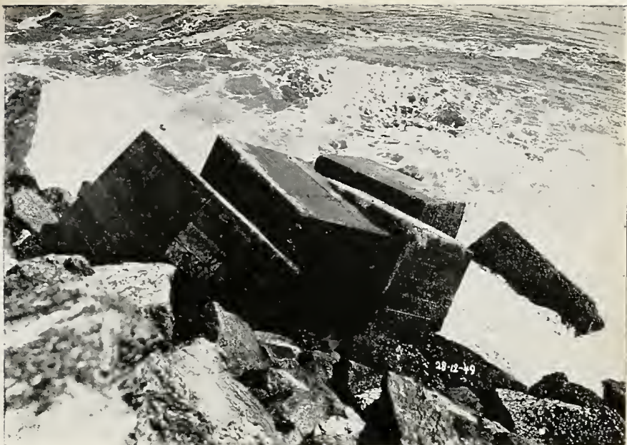
Pôrto de Itajaí — blocos de 25 toneladas lançados no cabeço do molhe Sul
