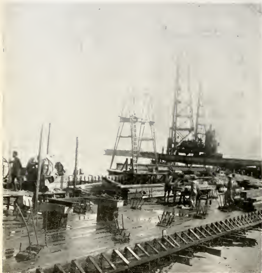
Molde de madeira da laje do "Pier", indicando as aberturas para execução do enrocamento
