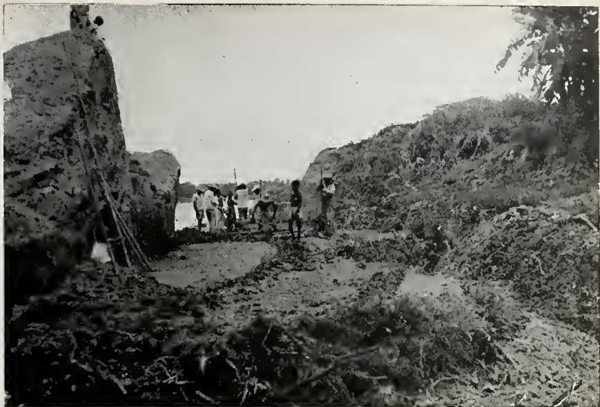
Desmonte de uma pequena ilha na boca do "Correnteza" no Amazonas
