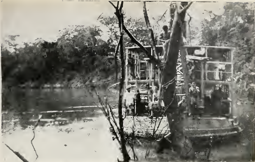
Remoção, pela draga "Gomes de Souza", de troncos de árvore do leito do rio Mearim
