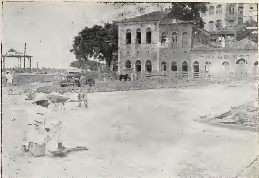
Pavimentação da área contígua ao cáis de Teresina
