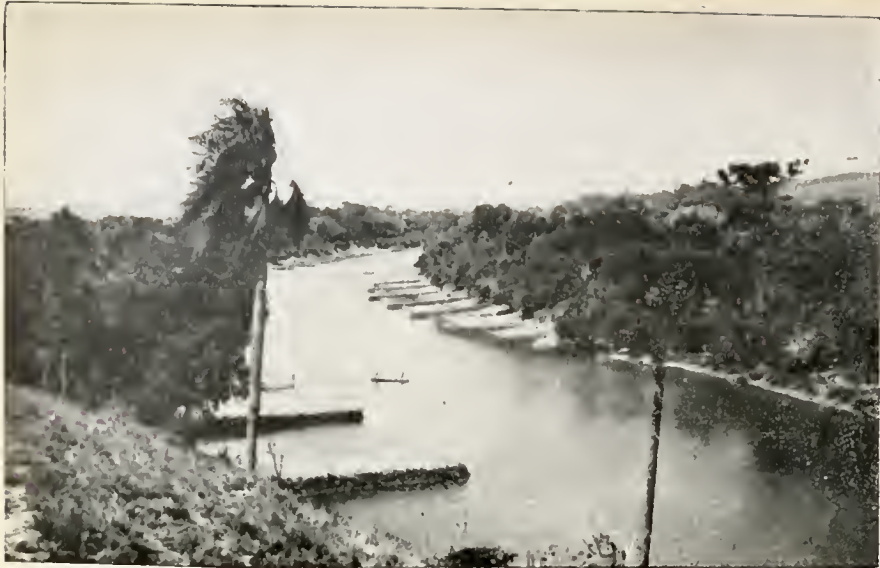
Paraná -- Rio Iguaçu — Trecho entre os quilômetros 3 e 4, regularizado com espigões
