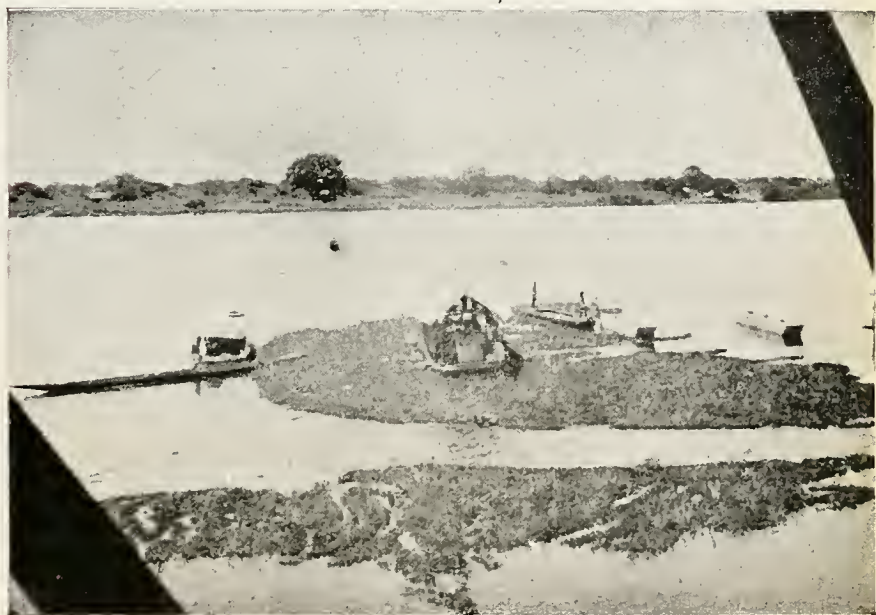
Corumbá — Vistas do assentamento dos caixões de concreto armado no alinhamento do caís
