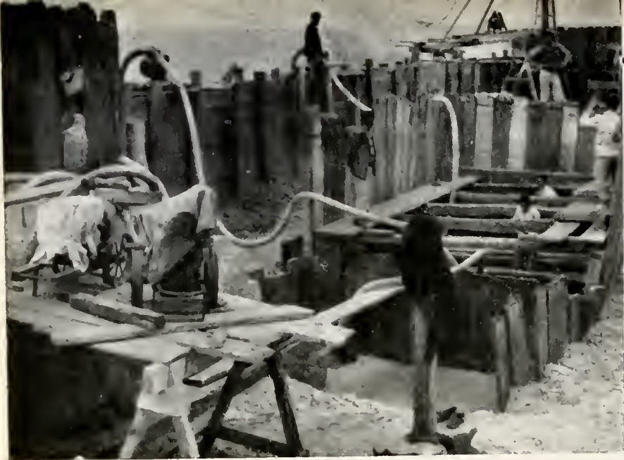
Santa Vitória do Palmar — Trabalhos de fundação do cãis
