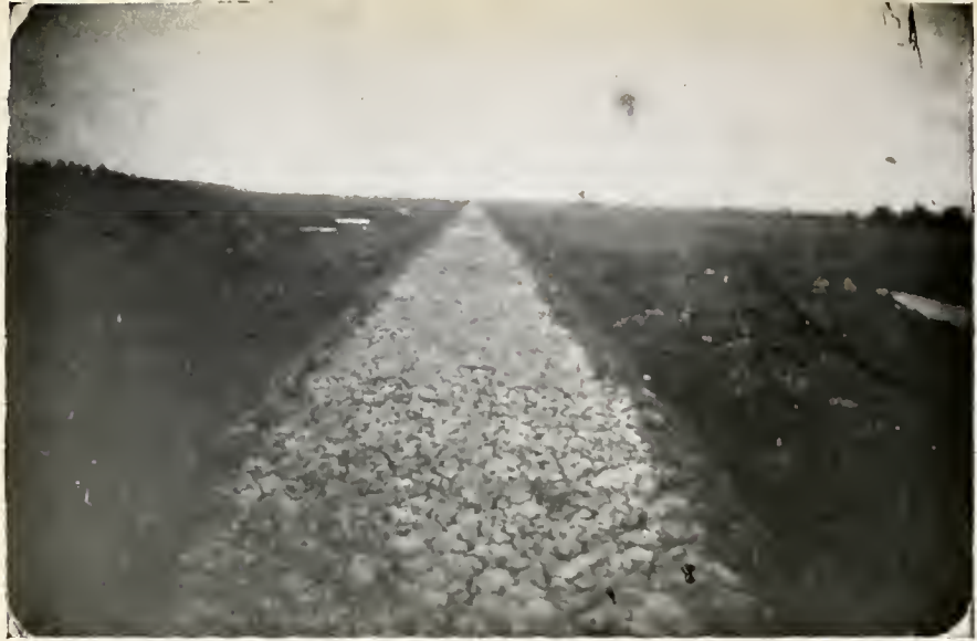
Dique de argila em Peri-Mirim
