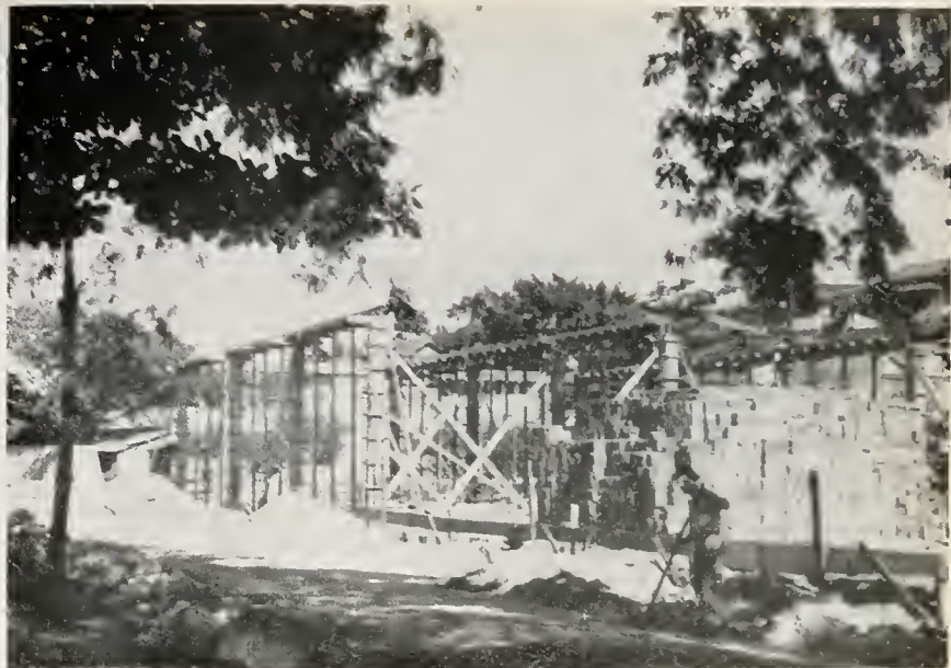
Construção do Laboratório de Hidráulica, no Cajú
