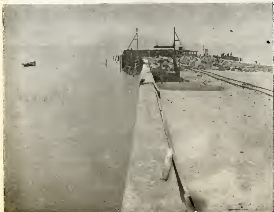
Santa Vitória do Palmar — Trecho do cãis concluído
