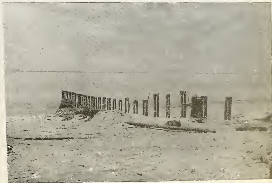
Paraíba — Praia de Camaláu — espigão em construção
