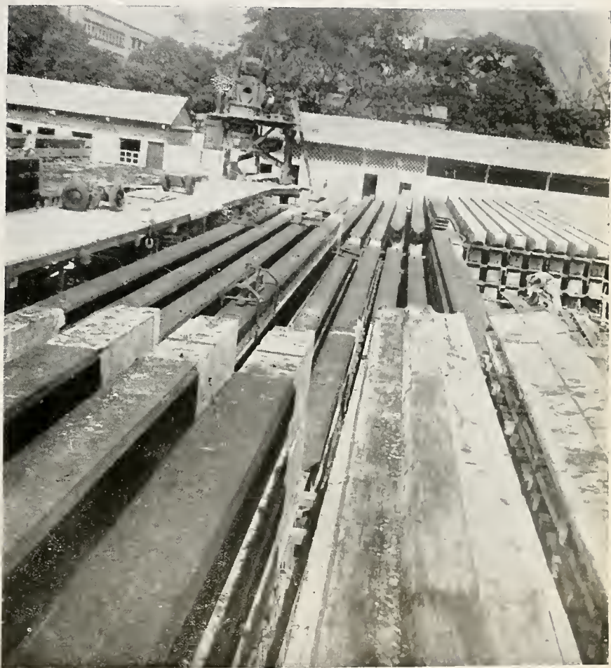
Canteiro para fundição das estacas e pranchas de concreto para o "Pier"
