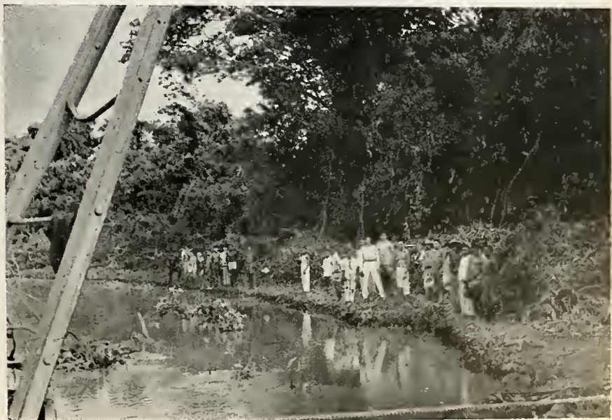
Serviços de limpeza das margens do rio Grajaú
