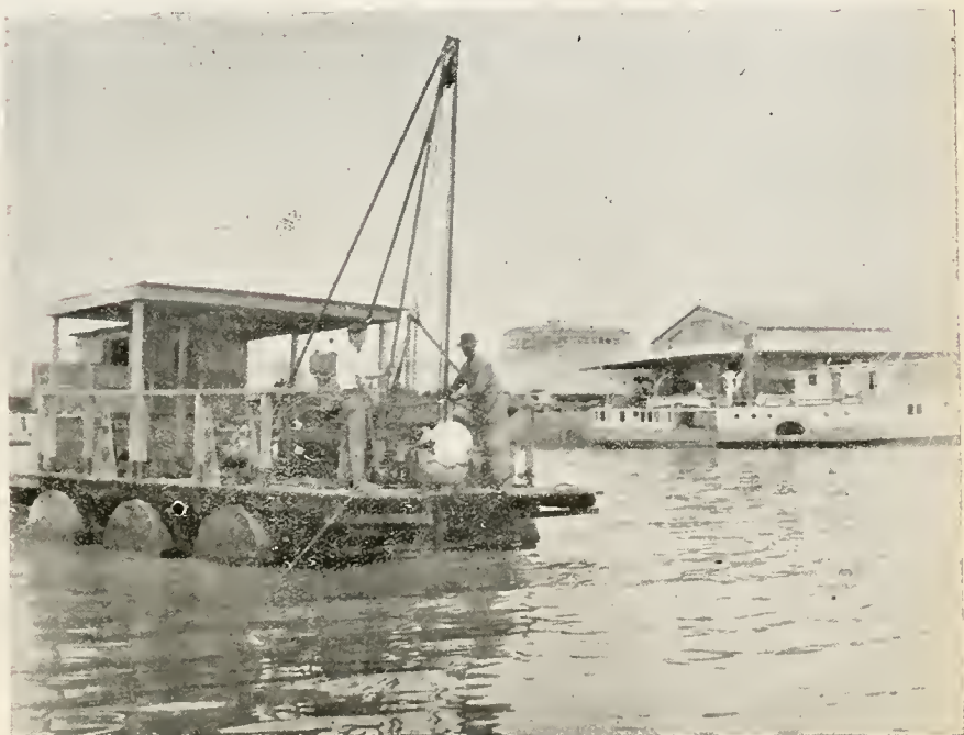
Pôrto Alegre — Sondagem geológica em frente ao cais
