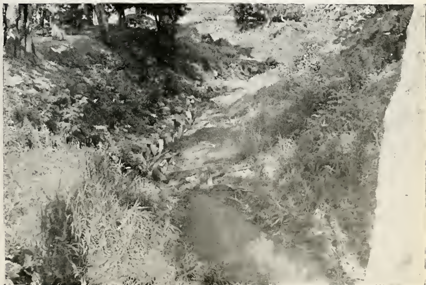
Abertura de canais de drenagem no "Correnteza"
