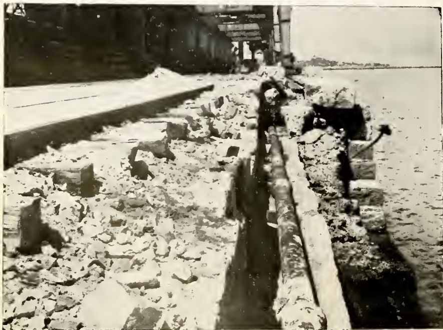
Recife — Trecho do cãis de 10 metros, avariado
