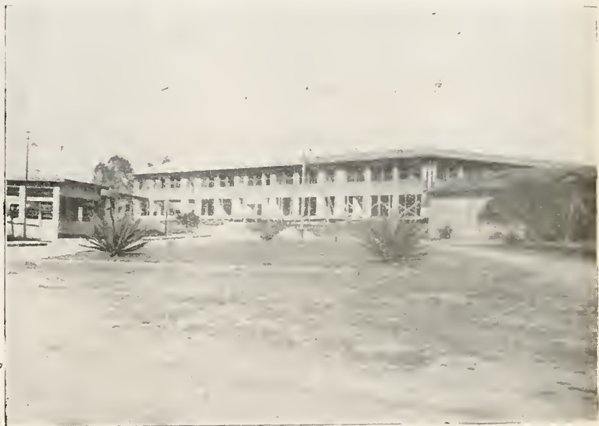
Construção do Almoarifado do D.P.R.C. — 13
