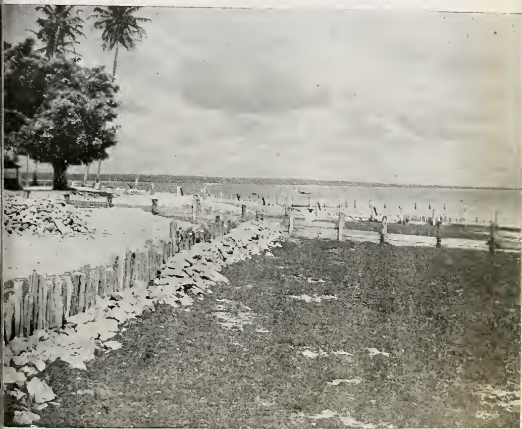
Praia Formosa — Lado sul de um espigão de "ponta do Mato", vendo-se a elevação do atêro
