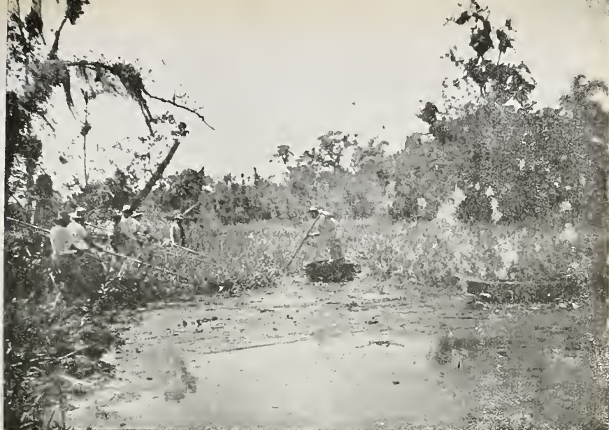
Santa Catarina — Rio Araçatuba, serviço de desobstrução
